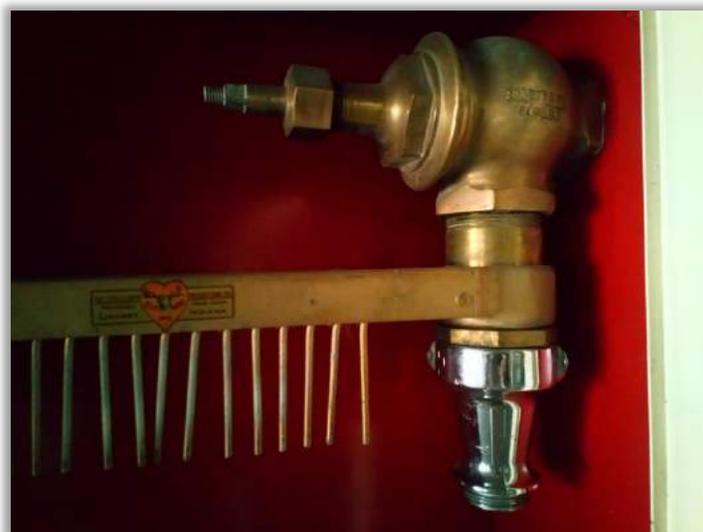
**Foto 3-9** Detalle de acople reductor de 63,5 mm (2 ½ pulg) a 38,1 mm (1 ½ pulg).
