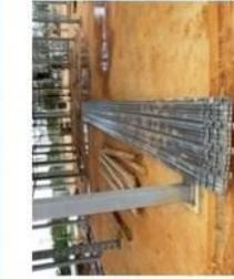
**Vigas tipo joist - producido por SIDETUR**
