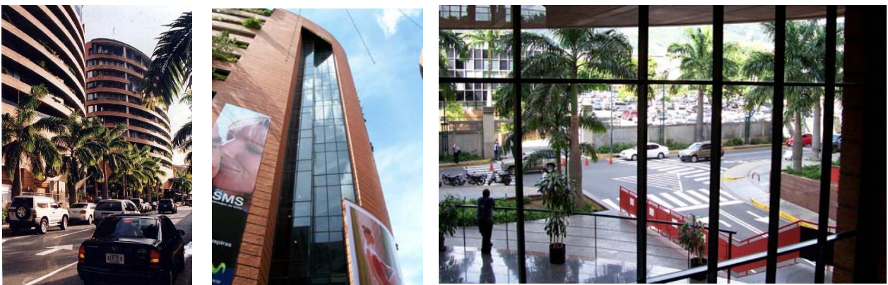
Imagen N° 11. Fotos fachada norte y sur, vista del hall al exterior –norte-. Fuente: Miguel Eduardo Reyes y Fernando González
