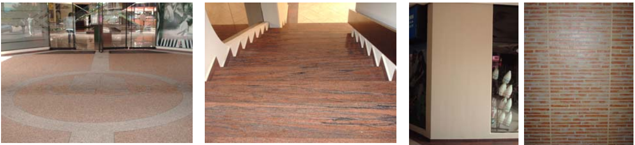
Imagen N° 17. Fotos pavimento exterior de canto rodado y puertas de vidrio, escalones revestidos de mármol pulido y paramentos de estuco y piezas pequeñas de arcilla Fuente: Alejandro Ordaz y Peter Havriluk
