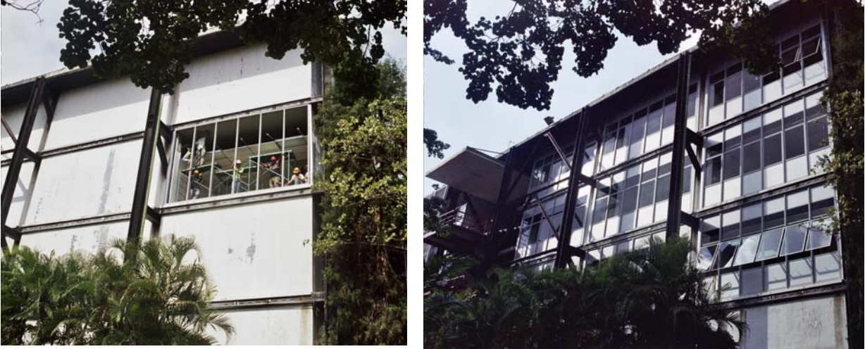
Figura 12 y 13. Vistas de la colocación de las ventanas en la esquina del extremo este de la fachada sur
