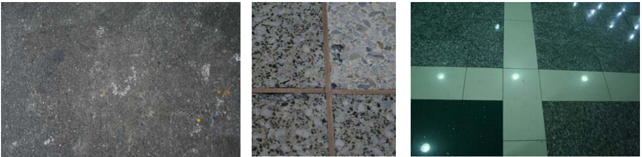
Imagen N° 6. Foto revestimientos de pavimentos exterior e interiores (granito vaciado con flejes plásticos y granito vaciado combinado con mármol y cerámica).
