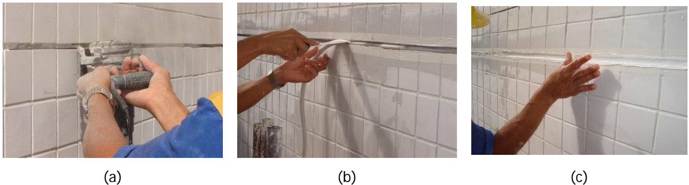
Figura 6 - Execução da junta de dilatação na Edificação E: corte do emboço através da maquita (a), inserção do limitador de profundidade das juntas de movimentação (b) e acabamento das juntas com as mãos, observando a presença da fita crepe protegendo a placa cerâmica (c).
