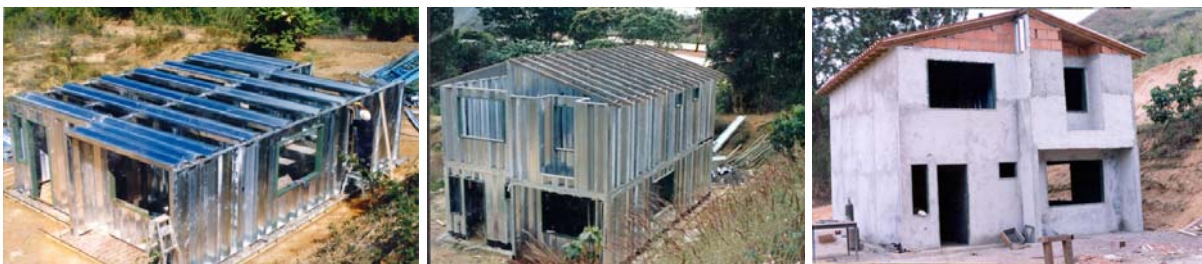
Proceso constructivo de vivienda Sipromat. FOTO: IDEC/ Sipromat (5)
