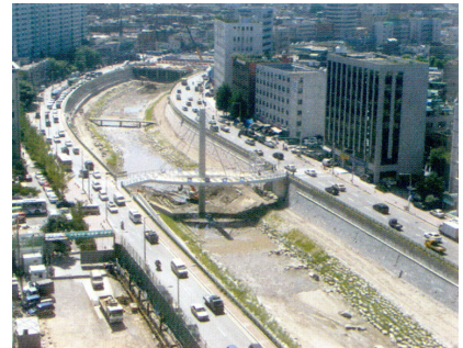
Img.34. Renovación del río en Seúl. Fuente: www.skyscrapercity.com
