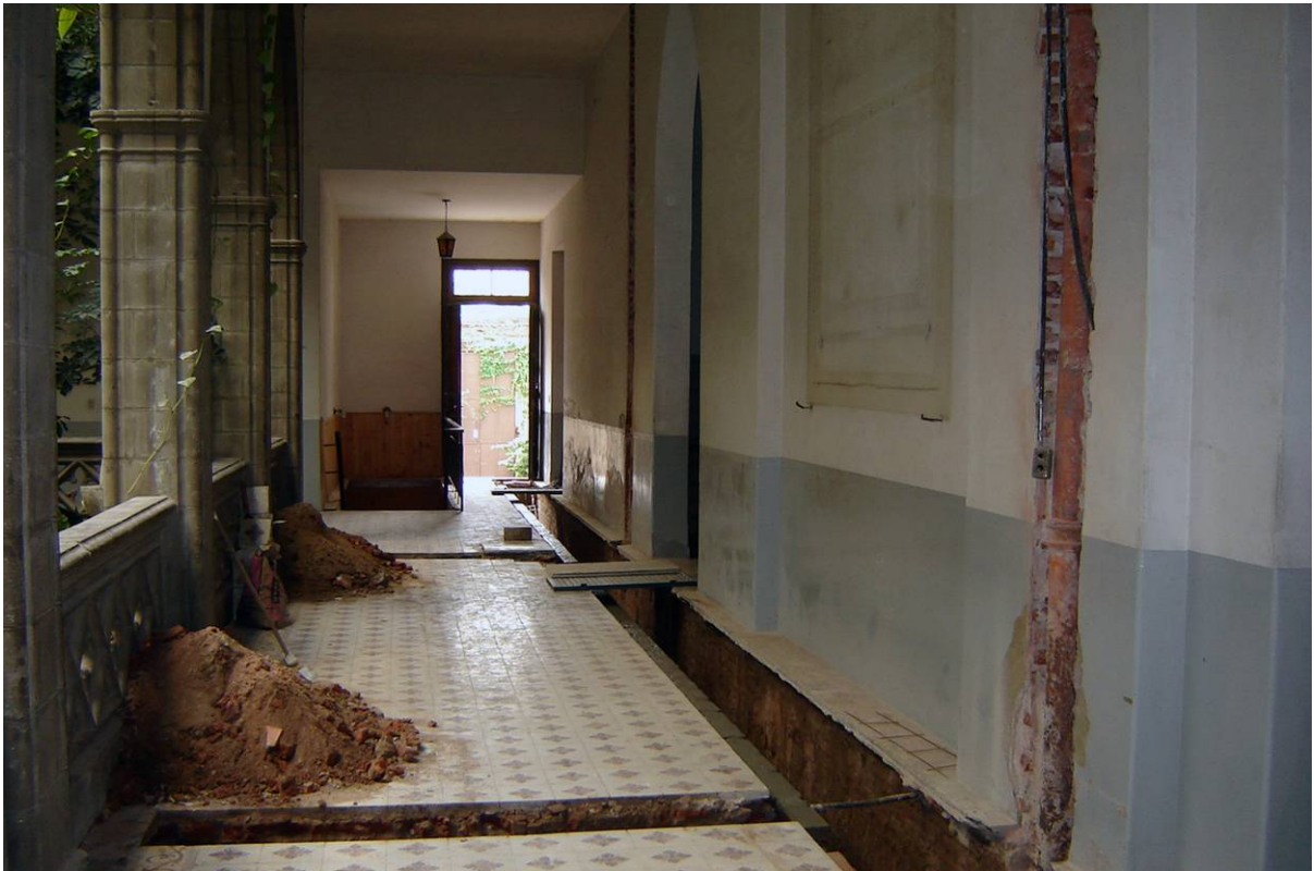
Foto 7. Ejecución de la Cámara Bufo.
