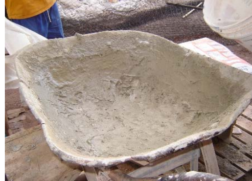
Figura 3 - Recipiente incrustado com resíduo, utilizado para mistura de argamassa na edificação E.
