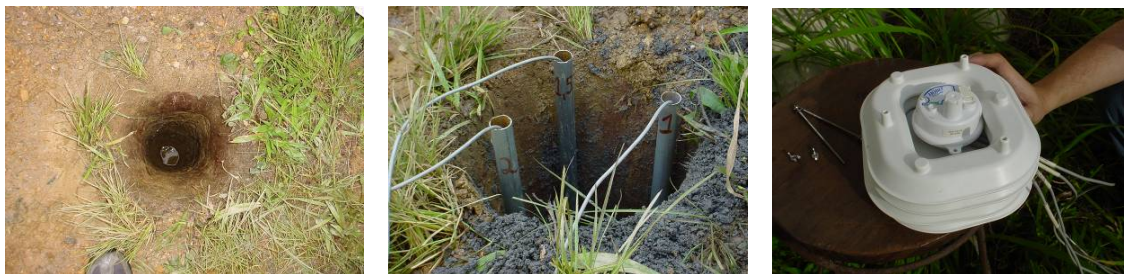
Figura 1.2.- Procesos de excavación y colocación de sensores. Fuente: Elaboración propia
