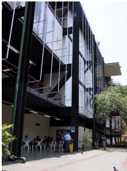
Figura 2. Foto de la fachada sur del edificio antes de ser intervenido Fuente: COPRED-UCV. 2005
