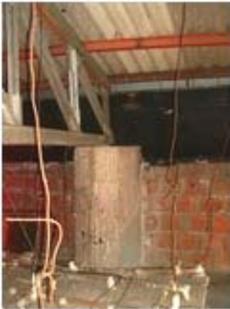
Foto 19. Vista interior de la estructura del la torre de la iglesia.
