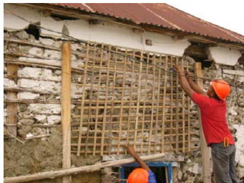
Figura 11: Retícula de varas sobre muro existente Capilla San Antonio, Edo. Zulia Fuente: Arquiluz, 2007
