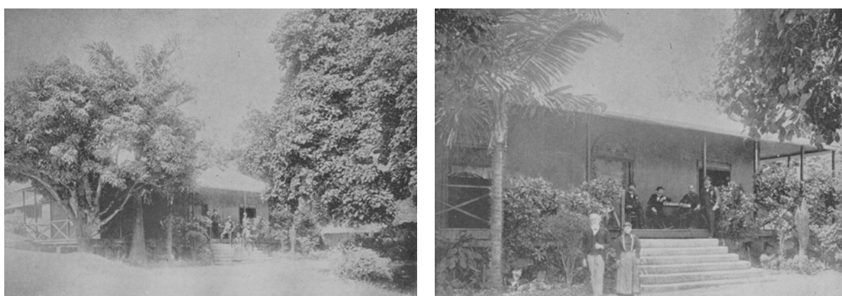
Imágenes 13 y 14. Baños Hidroterápicos de Caño Amarillo.
