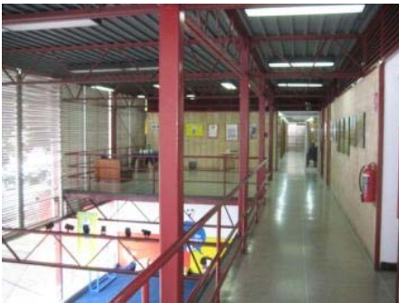
Imagen N° 2. Fotos de los pavimento de granito vaciado, barandas de acero, romanillas fijas con policromía de Carlos Cruz Diez.
