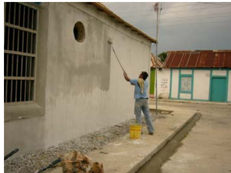
Figura 14: Aplicación pintura de caucho de tercera Capilla San Antonio, Edo Zulia Fuente: Arquiluz (2007)
