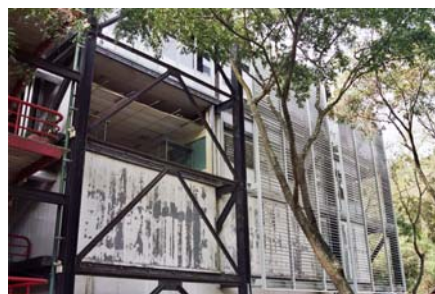
Figura 10. Vista de dos paños del sistema de protección solar Fuente: Arq. David Viloria
