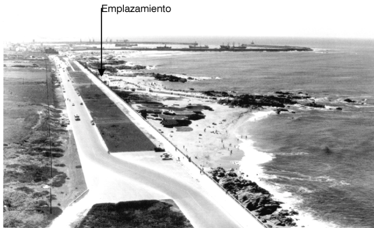
Figura 4. Vista de la Costa de Leça de Palmeira. Emplazamiento de las piscinas
