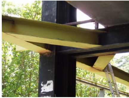
Figura 9. Vista Refuerzo Estructural Fuente: Proyecto del Arq. Rafael Urbina.
