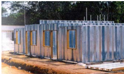
Viviendas en construcción Sabaneta. FOTO: IDEC/Sipromat (8)
