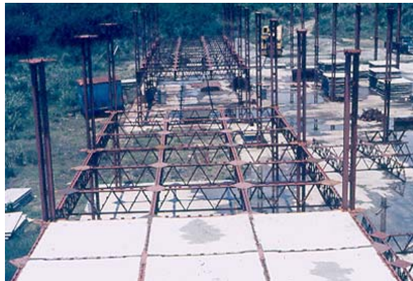
Figura 5 Construcción del ITUY, en San Felipe, con el sistema SIMAC Foto N. Dembo
