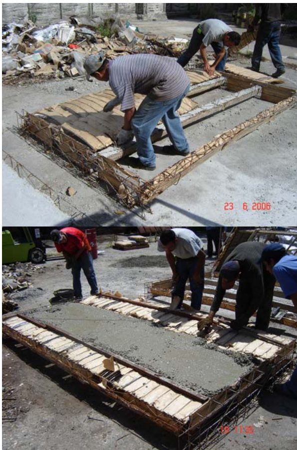
Figura 1 Proceso de construcción de la losa.
