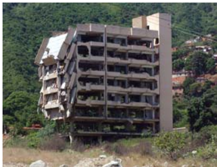
Edificio colapsado en Vargas.FOTO: Alberto Borrego (2)
