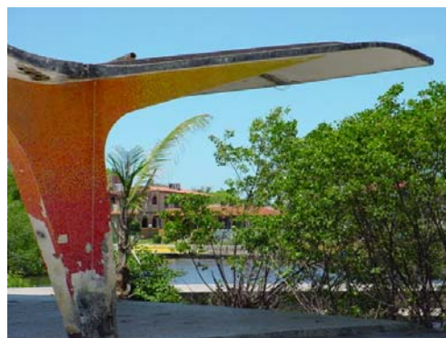
Figura 16: detalle del revestimiento con azulejos en la "Pergolita", 2003. Fotografía del autor.
