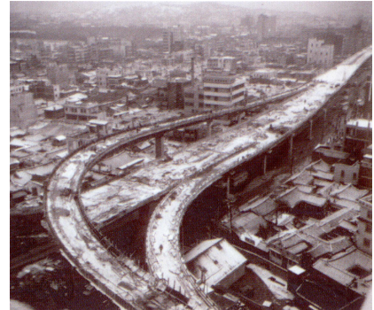
Img.32. Antigua autopista demolida en Seúl. Fuente: www.skyscrapercity.com
