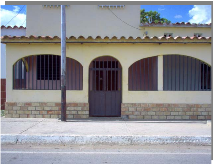
FOTO N° 1: Vista fachada principal Casa Sra. María López
