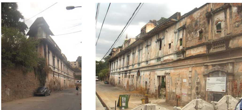
Imagen 16 y 17. Fachada Norte de la Almacénadora Santa Inés desde el Este y Oeste respectivamente.
