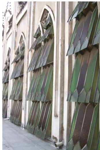
Foto 10. Ventanas en terrazas laterales que iluminan y ventilan la nave central.
