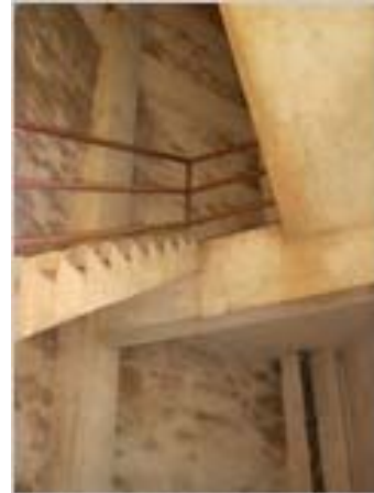
Foto 20. Detalle de soporte y armadura metálica de la cubierta.
