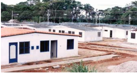
Viviendas en construcción Barinitas. FOTO: IDEC/Sipromat (7)
