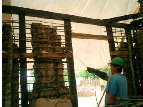
Figura 10: Encañado nuevo sobre relleno existente y desinfección con producto Xilamón Casa Natal R Urdaneta - Cañada, Edo Zulia Fuente: Arquiluz, 2007
