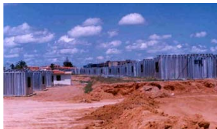
Viviendas en construcción Urb. Curagua. FOTO: IDEC/Sipromat (6)
