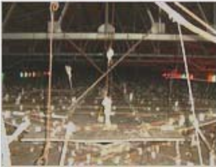
Foto 21. Vista sobre el cielo raso de la edificación.
