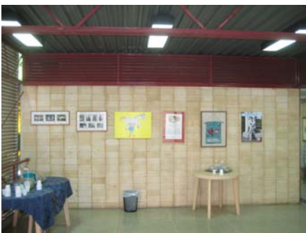
Imagen N° 3. Fotos de los tabiquería con paramento obra limpia de bloques de concreto con arena amarilla, ½ bóvedas de fibra de vidrio, romanillas fijas de aluminio.
