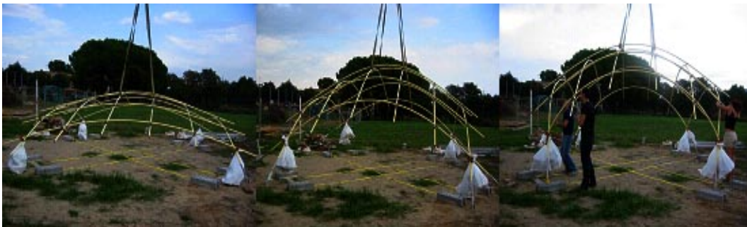
Fig. N° 22 Proceso de erección del prototipo Fuente: Elaboración propia
