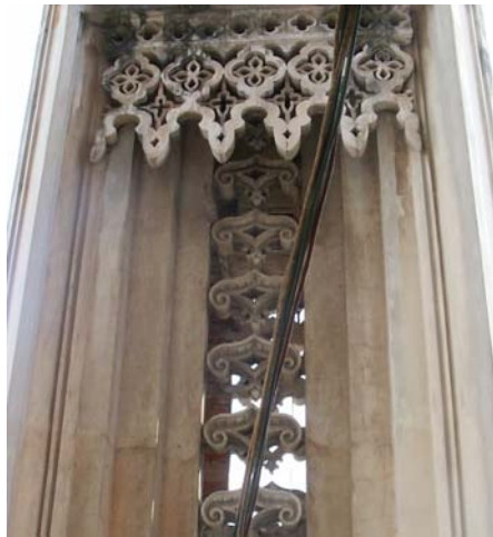
Foto 12. Ornamentos en obra limpia, en vacíos de torre central.
