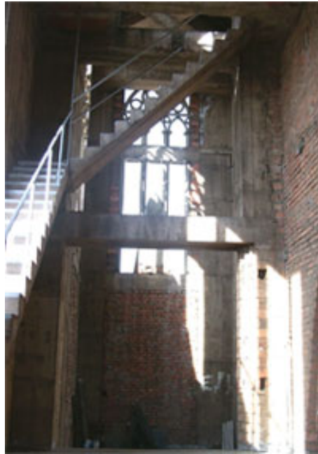
Foto 3. Muros y arcos ojivales en ladrillo macizo.
