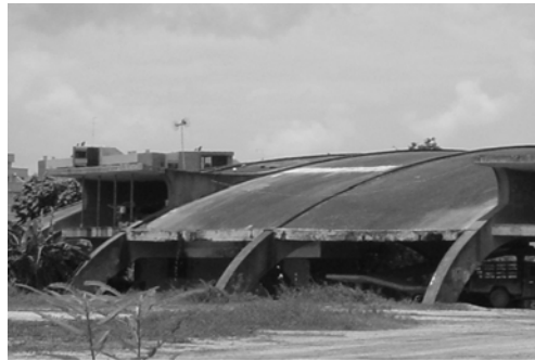
Figura 19: la Pérgola, 2003. Vista desde la calle. Fotografía del autor.
