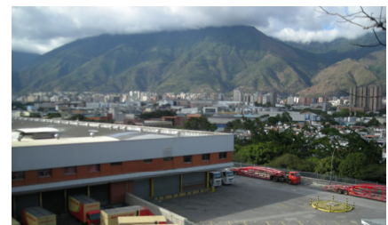
Img.23. Terreno Estratégico. Actual sede de Aerocav.
