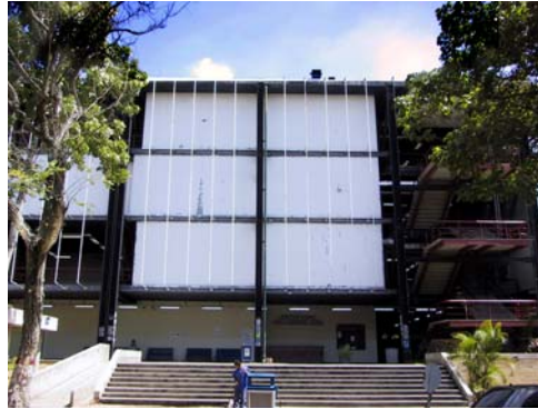
Figura 6. Fachada Sur. Vista del cerramiento externo de la edificación con láminas de acero galvanizado
