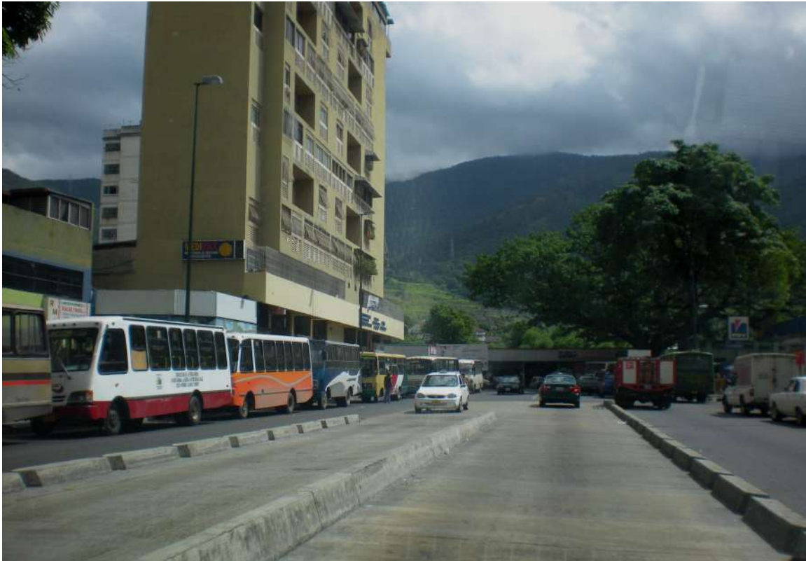
Figura 6. Obras del BusCaracas, Av. Fuerzas Armadas, Mercado de Las Flores.
