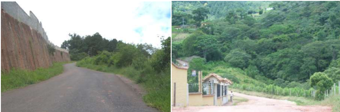
F1 y F2 Formas irregulares de la vías del sector. Fuente: Equipo de trabajo. Julio 2010
