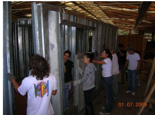
Fotos 14 y 15. Montaje de paredes portantes Sipromat Fuente: Propia
