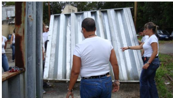
Izando un plano portante Sipromat y en una explicación en planta
