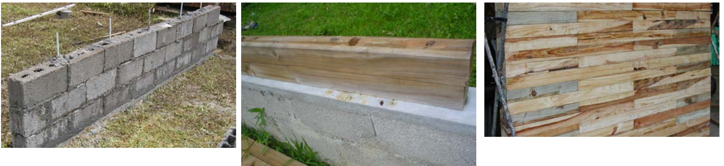
Fig 14. Detalles del proceso de construcción de la Pared
