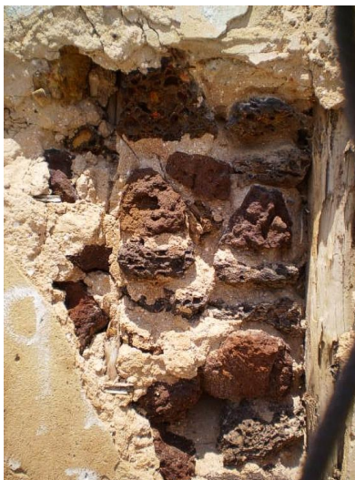
Foto 8: Relleno de barro, piedra de ojo y cal – Casa en Maracaibo (Fuente: Elaboración de la autora)
