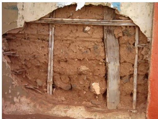
Foto 4: Vara auxiliar vertical entre horcones – Casa en Puertos de Altigracia (Fuente: Elaboración de la autora)
