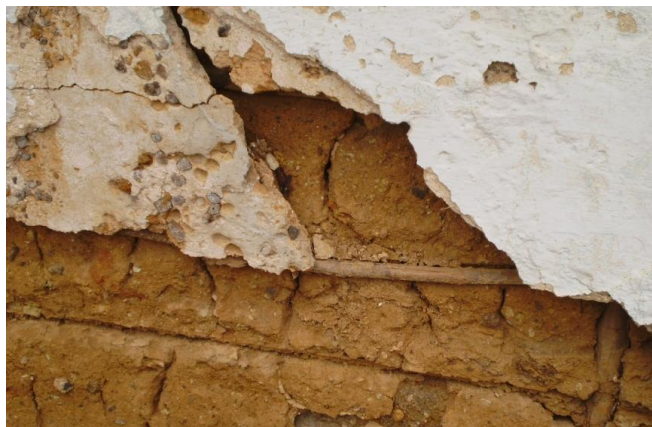
Foto 9: Empañetado base y empañetado final - Casa en El Bajo (Fuente: Elaboración de la autora)
