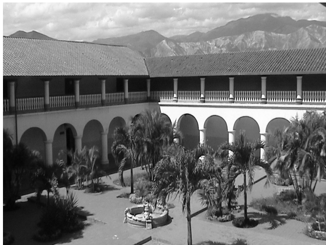
Foto 5. Claustro del Convento de El Tocuyo. Fuente: Archivo fotográfico del autor.
