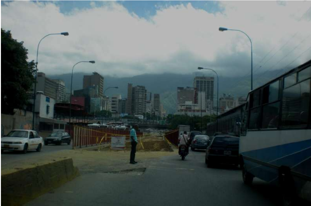
Figura 7. Obras del BusCaracas, avenida Fuerzas Armadas (Foto de las autoras, 2010)
