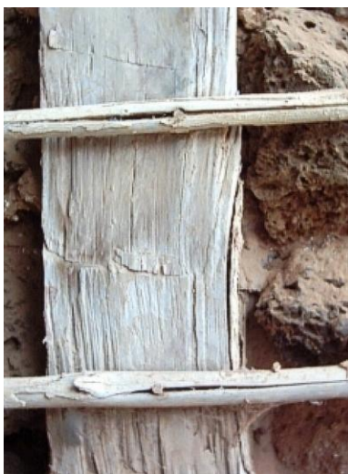
Foto 7: Varas clavadas al horcón – Casa en Puertos de Altagracia (Fuente: Elaboración de la autora)
