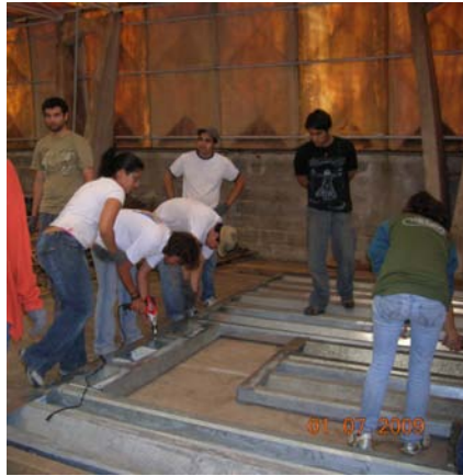
Fotos 16 y 17. Fijaciones de paneles portantes Sipomat Fuente: Propia
