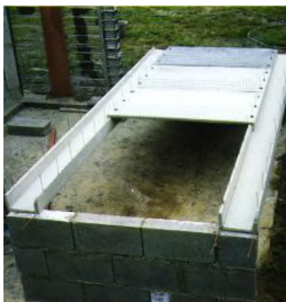
Figura 1: Componentes de entrepiso y techo en ferrocemento (Fuente: Foto tomada por Laura Ramirez)
