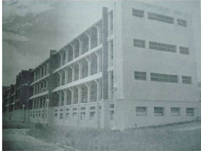
Foto 2. Fachada posterior Sanatorio antituberculoso "Venezuela". Mérida Fuente: Ministerio de Obras Públicas (1948). Memoria y Cuenta. Gráfica. Imprenta Nacional
