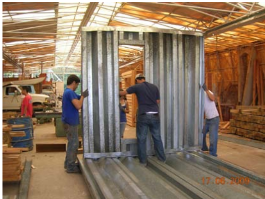
Fotos 14 y 15. Montaje de paredes portantes Sipromat Fuente: Propia
