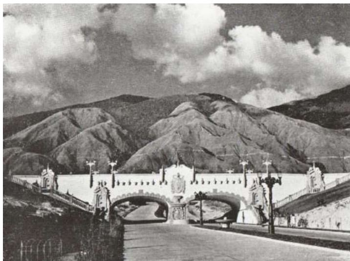
Figura 5. Los Caobos, Avenida Principal y Puente Bolívar en 1942. Fuente: Roche, 1967: s/n.
