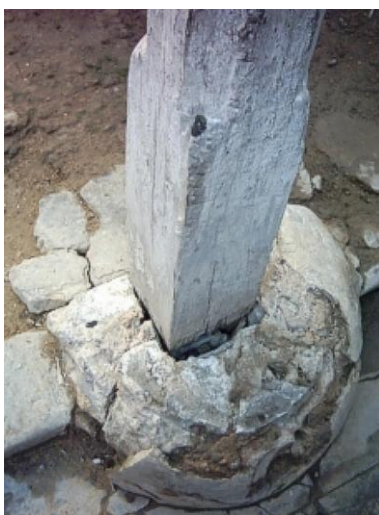
Foto 1. Horcón cuadrado de curarire – Casa en el centro de Maracaibo (Fuente: Elaboración de la autora)
