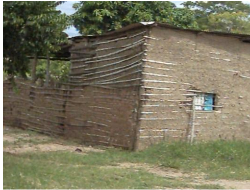
Foto 5: Vivienda rural sin varas verticales – Casa a lo largo de carretera Lara-Zulia (Fuente: Elaboración de la autora)
