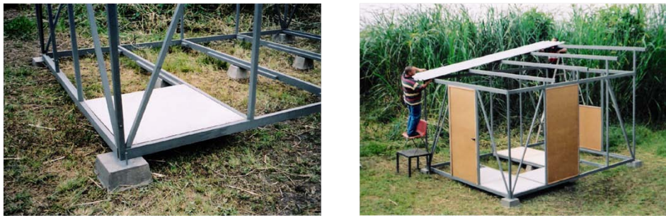
Figura 18. Detalle cerramiento piso. Ejemplos de cerramientos. F: Ana Marrero
