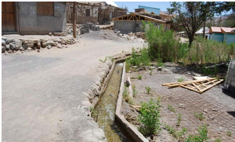
Figura 15. Mocha. El canal que pasa por el pueblo, en la parte superior. Fotografía. R. Chandía
