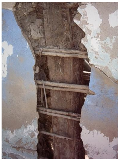
Foto 3: Enlatado con dos varas – Casa en El Carmelo (Fuente: Elaboración de la autora)
