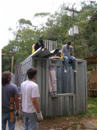
Foto 3. Deconstrucción de prototipo Sipromat Fuente: Propia
