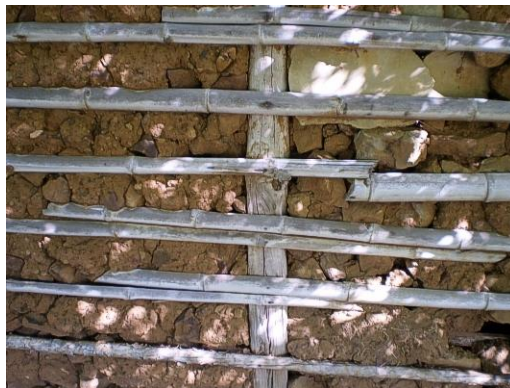
Foto 2: Enlatado delante del horcón – Casa en Los Dulces (Fuente: Elaboración de la autora)
