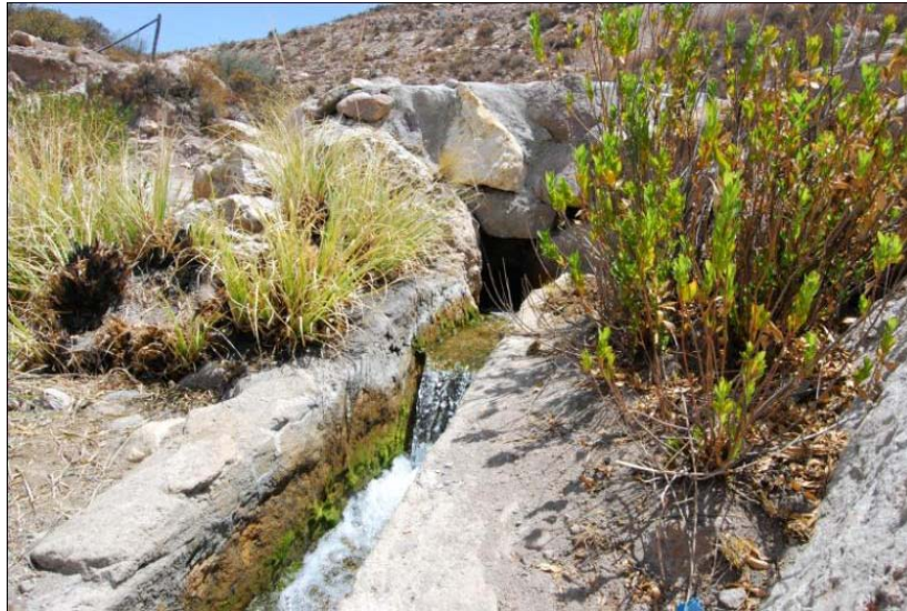
Figura 6 Socoroma. La salida de un ducto subterráneo de captación, para distribuirse en el territorio. Foto: R. Chandia, (2009)
