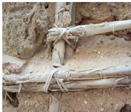
Foto 6: Uniones cruzadas hechas con bejuco – Casa en el centro de Maracaibo (Fuente: Elaboración de la autora)
