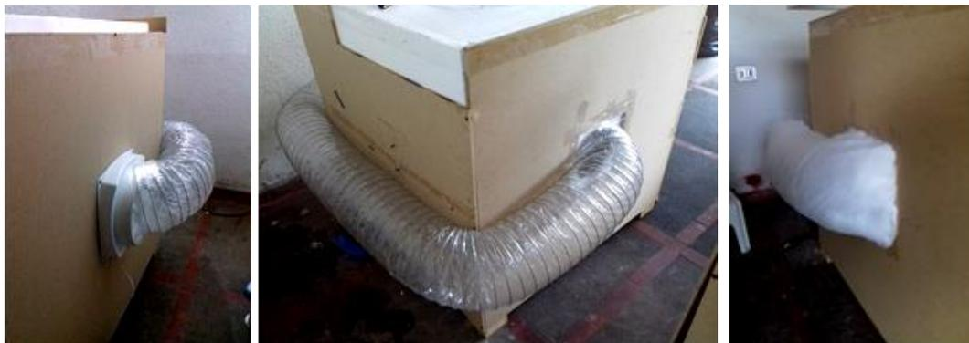
**Figura 5:** Ventilador y ductería flexible en Módulo ventilado (MV), y ductería posteriormente revestida con material aislante. Fuente: elaboración propia.
