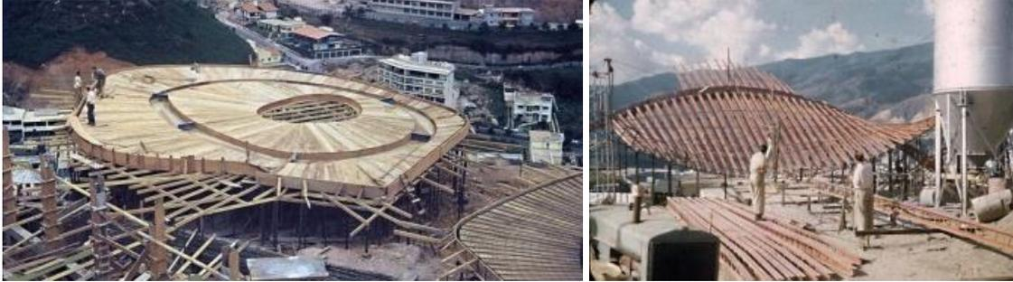
**Figura 3.** “El Rancho”, Club Táchira, ca. 1955. Construcción de plataformas (izq.) y montaje de cerchas del techo conoidal (der.). (Fotografías tomadas de: Remón Royo et Al., 2016).
