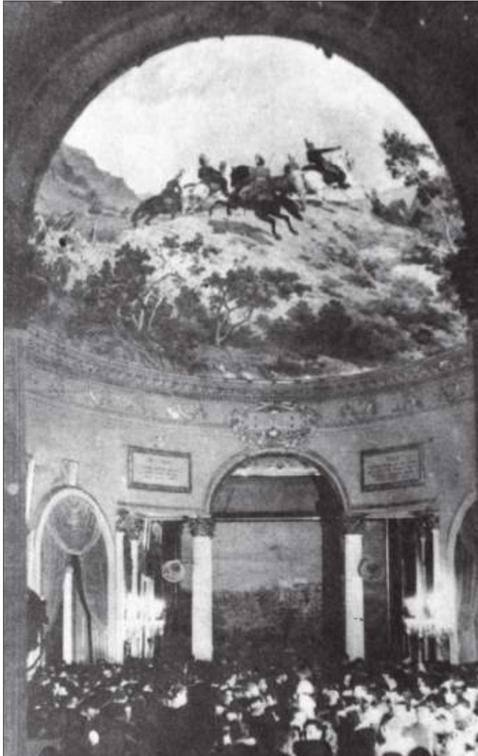
154← Vista del Salón Elíptico hacia el oeste, en los años 50; se aprecian los cambios en la decoración de los muros, así como la instalación de marcos falsos en puertas y ventanas y la adición de cortinajes en las puertas.
