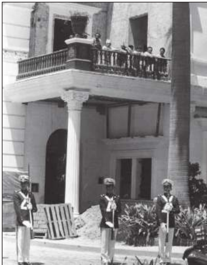
100← Según proyecto del arquitecto Oscar Bracho se modifica entre 1989-1992 el ala noroeste del Palacio Federal ocupada por la Presidencia del Senado. Allí se demuelen muros internos, se colocan nuevos tabiques, puertas, ventanas y pisos, se cambia la escalera de acceso desde el vestíbulo norte y se horada la azotea para colocar una linterna cónica sobre el despacho principal, ca. 1990.
