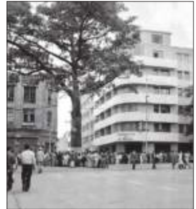
122↑ En la esquina La Bolsa, el ingeniero Gustavo Marturet proyecta un edificio de igual denominación, con 7 pisos, pasaje peatonal, comercios, oficinas y viviendas.
