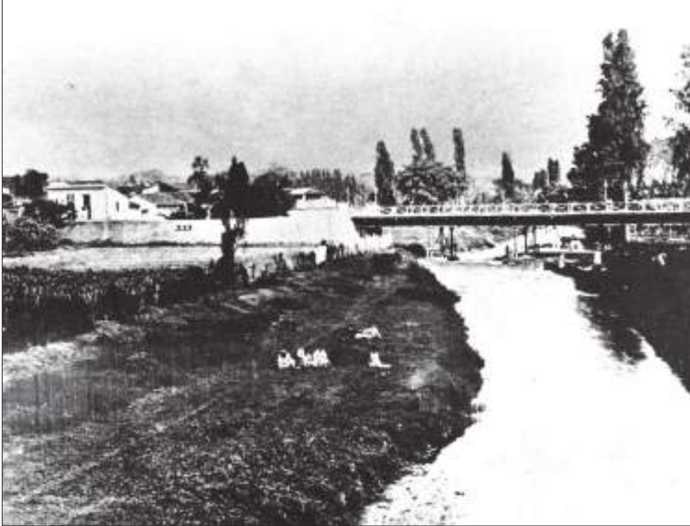
17← Vista del Puente Regeneración sobre las amplias riberas del río Guaire, realizado en 1875, luego conocido como Puente Hierro, en la parroquia Santa Rosalía.
