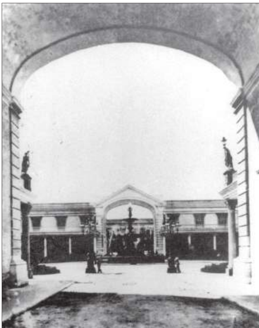
47 ← Bajo el intradós del arco lateral que vincula ambos Palacios se visualizan las alas laterales y la fuente ornamental en el patio central 1890
