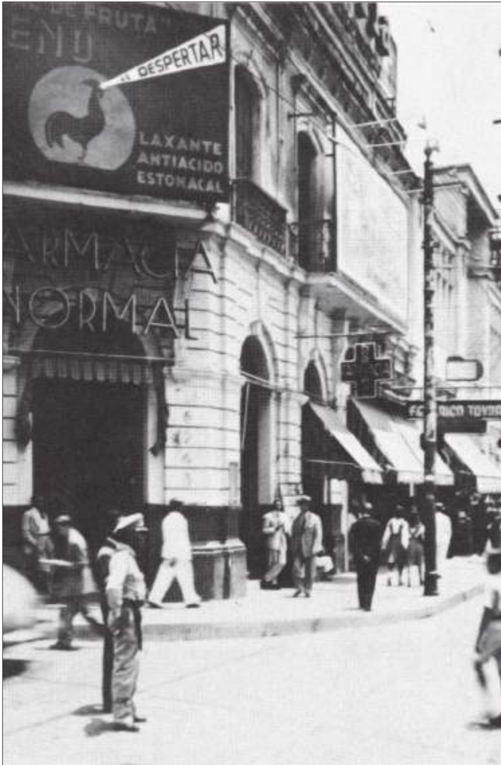
120 ← Para 1944 es demolido el inmueble ubicado en la esquina Padre Sierra, para levantar un moderno edificio de cinco pisos diseñado por el arquitecto Rafael Bergamín.
