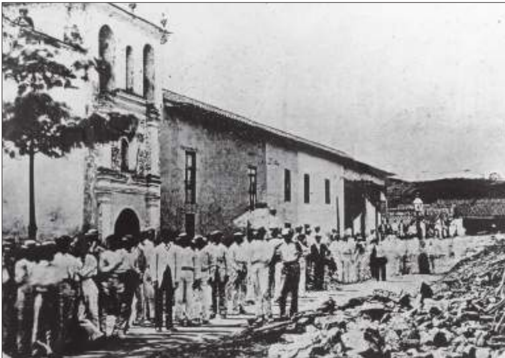
22 ← Vista desde la esquina San Francisco hacia el oeste, donde se aprecia la demolición de la parte sur del Convento de La Concepción y de la capilla posea del antiguo Convento de San Francisco, ahora Universidad de Caracas.
