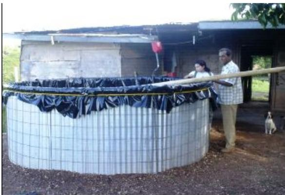
**Figura 13.** Construcción de tanques artesanales zamoranos.
