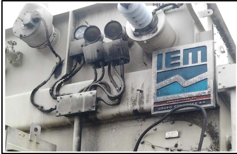
Figura 14. Indicadores de temperatura del aceite y devanados.
