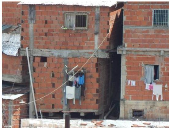
Figura 2. Acero de refuerzo expuesto e instalaciones de aguas servidas improvisadas
