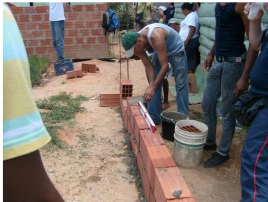
Figura 13. Proceso de construcción de una pared de bloques de arcilla
