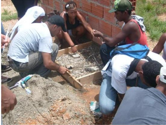
Figura 12. Encofrado y armado de la malla para losa de fundación.
