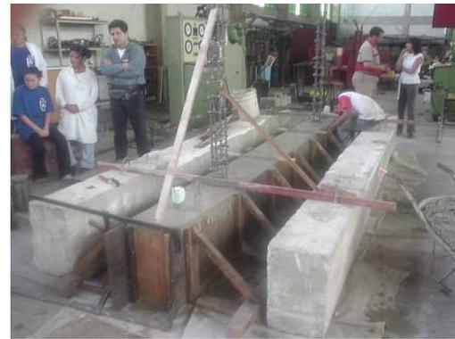
**Figura 24 Viga de Fundación Vaciada**
