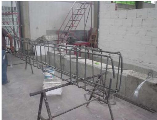
**Figura 17 Armado Viga de Fundación**
