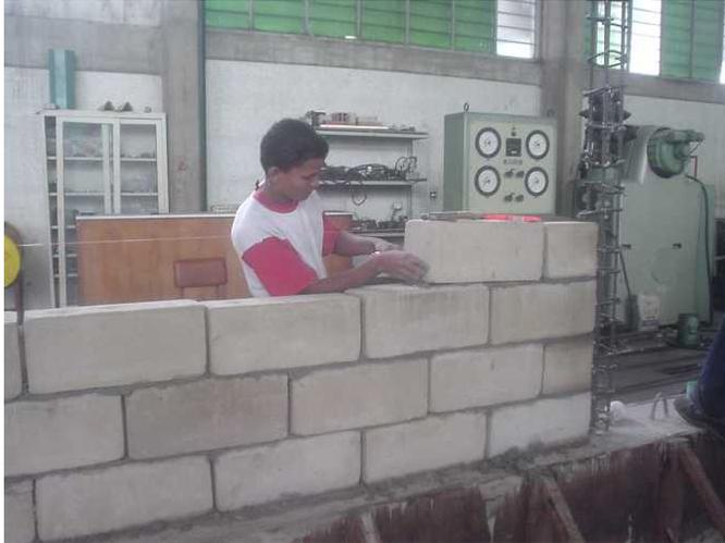
**Figura 25 Construcción del Paño de Mampostería sobre Viga de Fundación**
