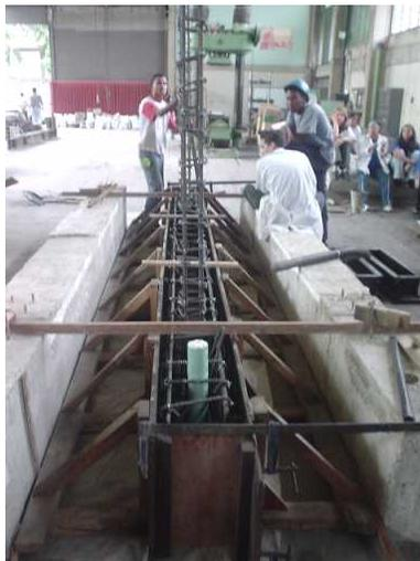
**Figura 20 Armadura de Viga de Fundación dentro de Encofrado de Madera**
