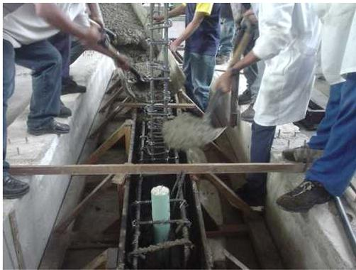
**Figura 23 Vaciado de Viga de Fundación**
