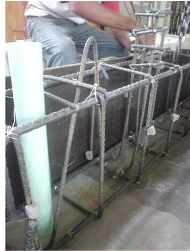
**Figura 22 Separadores Amarrados a armadura de Viga de**
