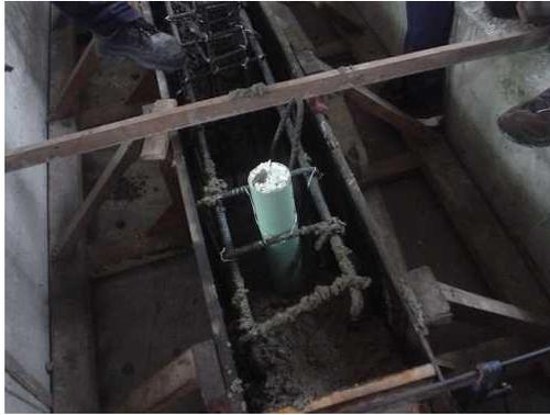
**Figura 18 Tubo de diámetro 3" para anclaje**
