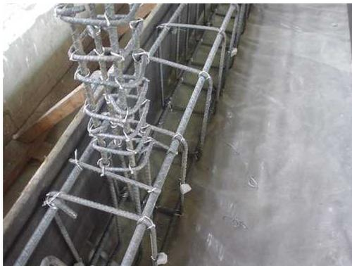
**Figura 19 Armadura de Machón enlazada a armazón de viga de fundación**
