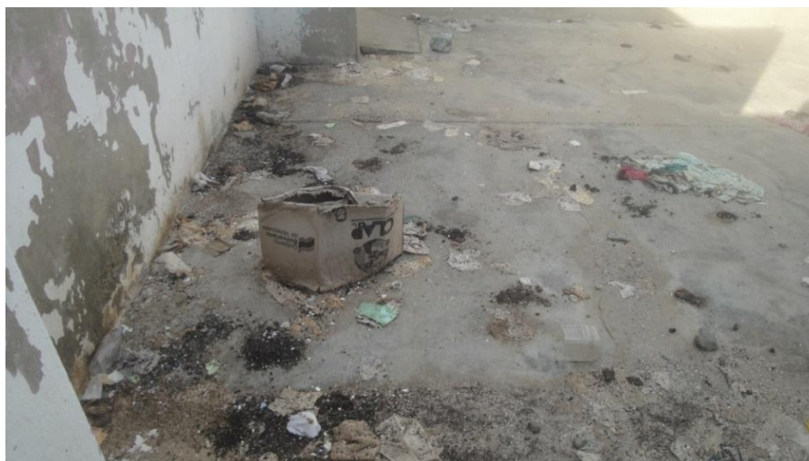
Teatro del bulevar. Fuente: elaboración propia (septiembre 2018)
