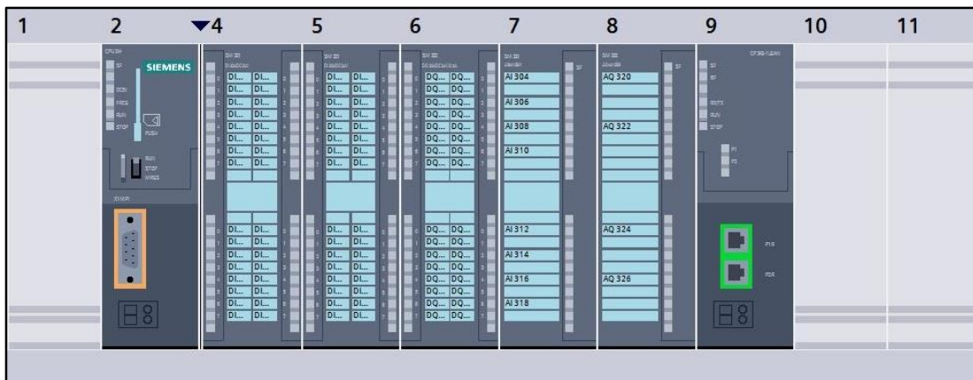
Figura 5.5: Bastidor en la estación para tanques de licor.
