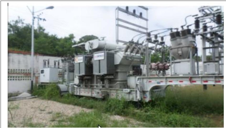
**Figura 20:** Transformador Móvil
