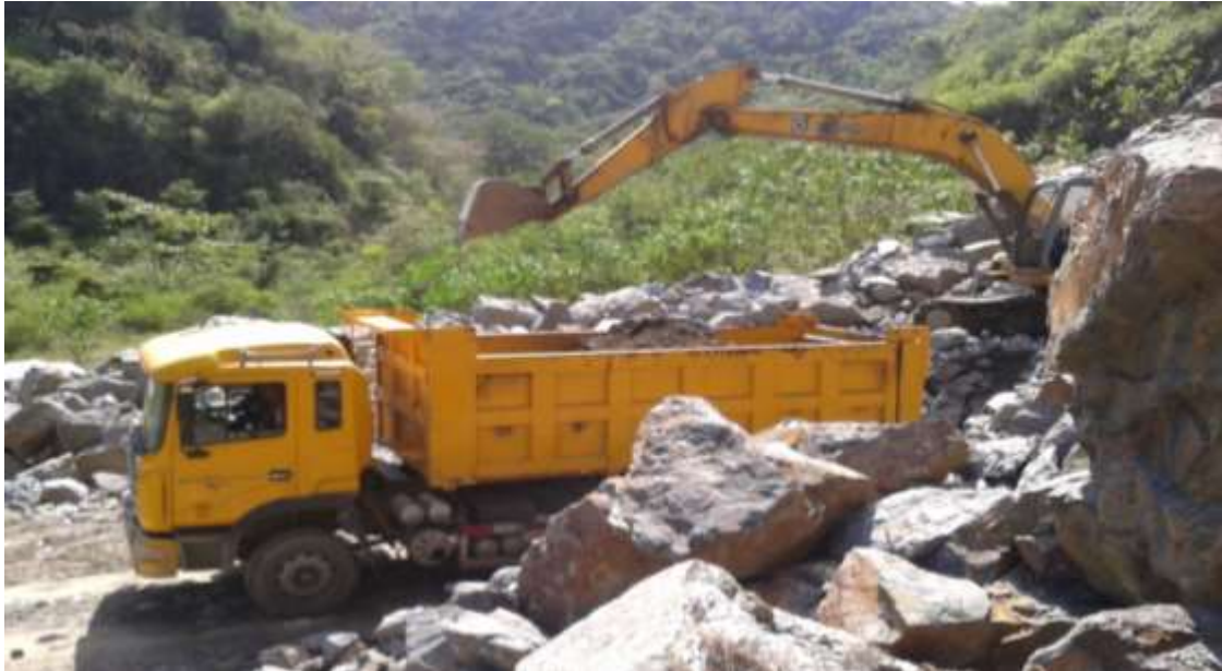
Figura 3. Retroexcavadora XCMG-XE230 realizando la carga del camión JAC. Fuente: Propia, 2018.
