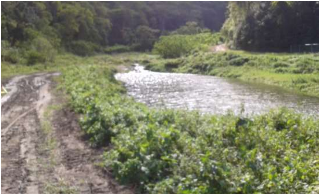
Figura 15. Altura relativa del agua del cauce con respecto a la vialidad. Elaboración: Propia.
