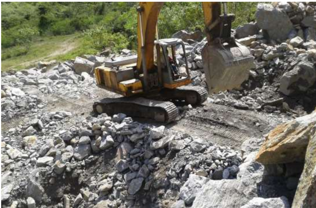
Figura 18. Excavadora clasificando el material por tamaños, a su izquierda el considerado admisible por la planta. Elaboración: Propia.
