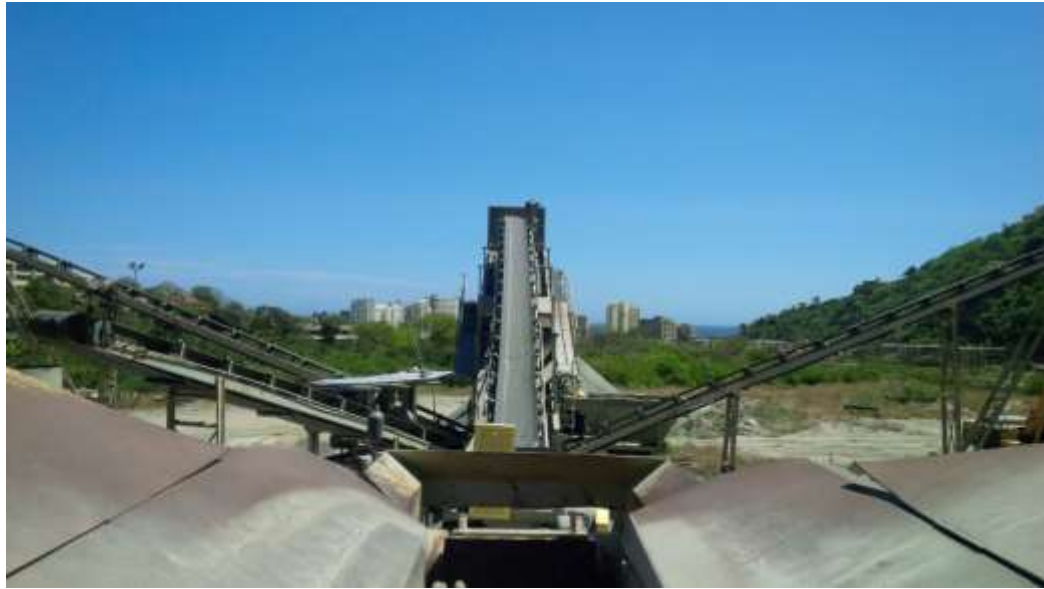
Figura 9. Vista de la planta desde el Alimentador. Elaboración: Propia.
