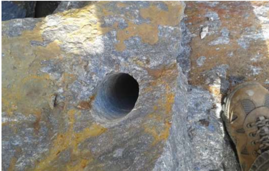
Figura 17. Vestigio de voladura realizada en la cantera Camurí Grande. Elaboración: Propia.
