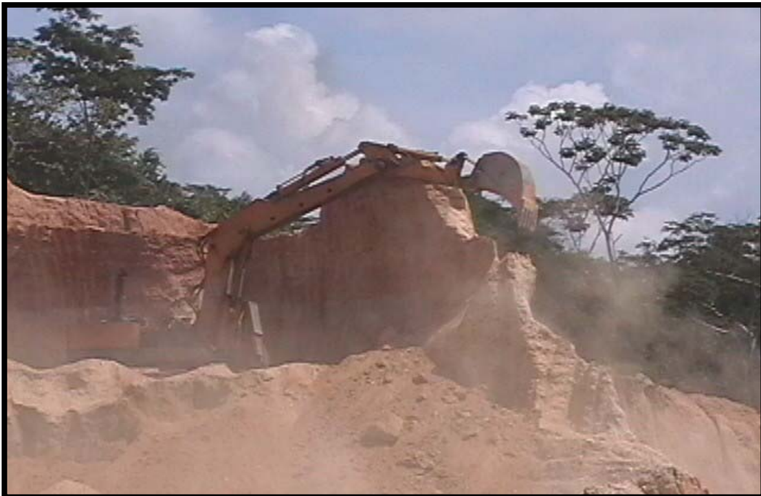
Fig. 26. Explotación de gravas y arenas donde se observa que se cortan los niveles contaminantes infrayacentes sin ningún control minero.
