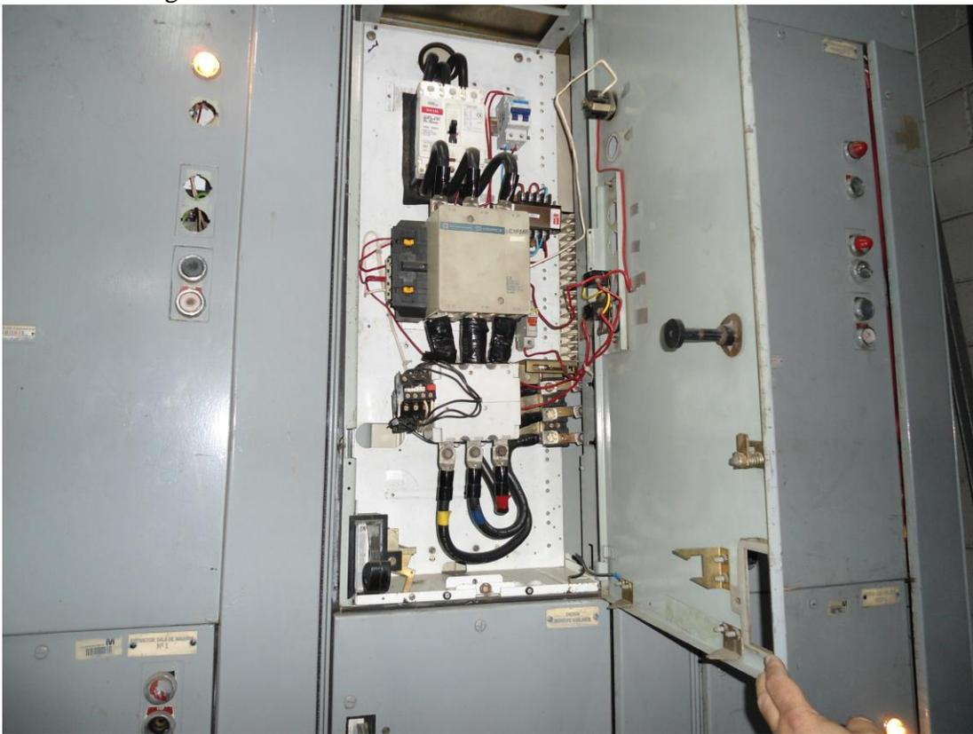
Figura 29 Tablero de control de bomba de condensado de agua en Planta de Refrigeración 1 Metro de Caracas
