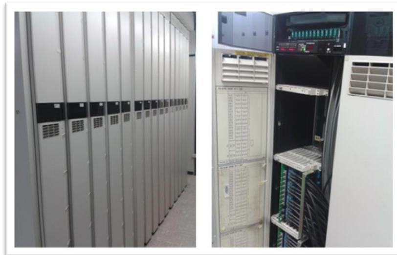
Figura 25. Equipos PDH marca NEC central CNT
