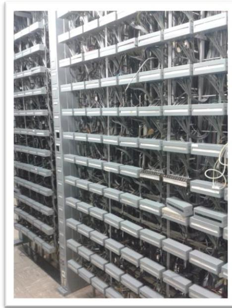
Figura 24. DDF marca TELETTRA central CNT
