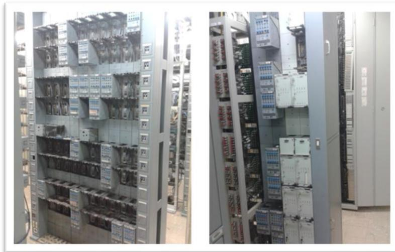
Figura 23. Equipos PDH marca TELETTRA central CNT
