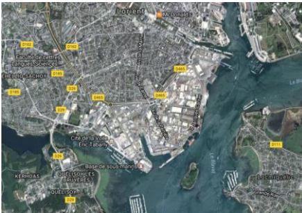
Figura 26. Base de submarinos de Lorient vista reciente del Búnker Keroman I. Fuente: XIIIfromTokyo. (2018).
