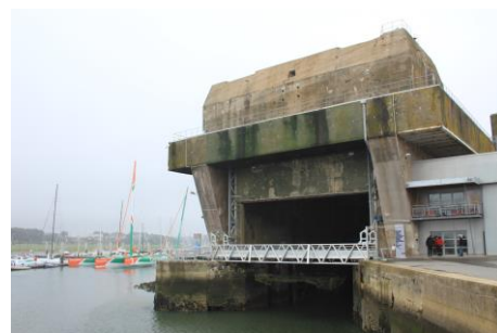
Figura 29. Base de submarinos de Lorient vista reciente del Búnker Keroman I. Fuente: XIIIfromTokyo (2018).
