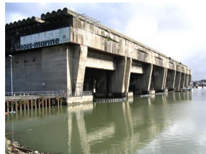
Figura 24. Vista reciente de los Fangrost en la cubierta de la base submarina de Burdeos. Fuente: http://en.tracesofwar.com/htm (2014).
