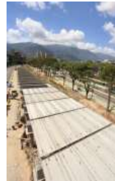
Figura No 16. Resultado de la cobertura aplicada al cauce del río El Valle, a la altura del Paseo Los Ilustres..
