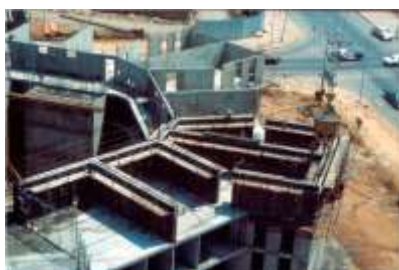
Figura 8: Sistema de paredes portantes Simix (fuente propia)
