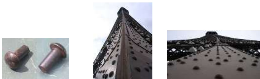
Figura 4. Roblones de acero Fuente: https://es.wikipedia.org/w/index.php?title=Detalle de la Torre Eiffel en la que se aprecian los roblones en las uniones, un total de 2 500 000 unidades. Fuente: https://es.wikipedia.org/w/index.php?title=Detalle de la Torre Eiffel Fuente: http://www.infojardin.com/ Recuperados el 04 de Marzo 2016.
