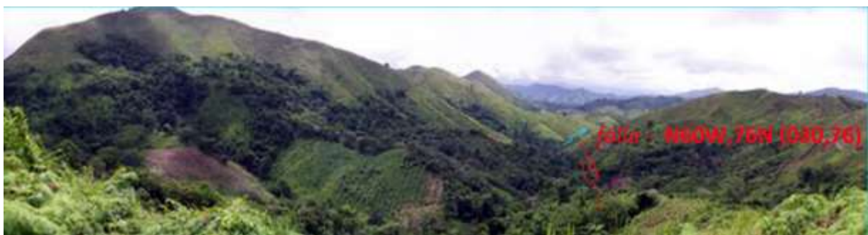
Figura 5.37 Vista panorámica de la zona de presa donde se puede observar la ubicación de una falla rumbo N60W, 76N (030,76)
