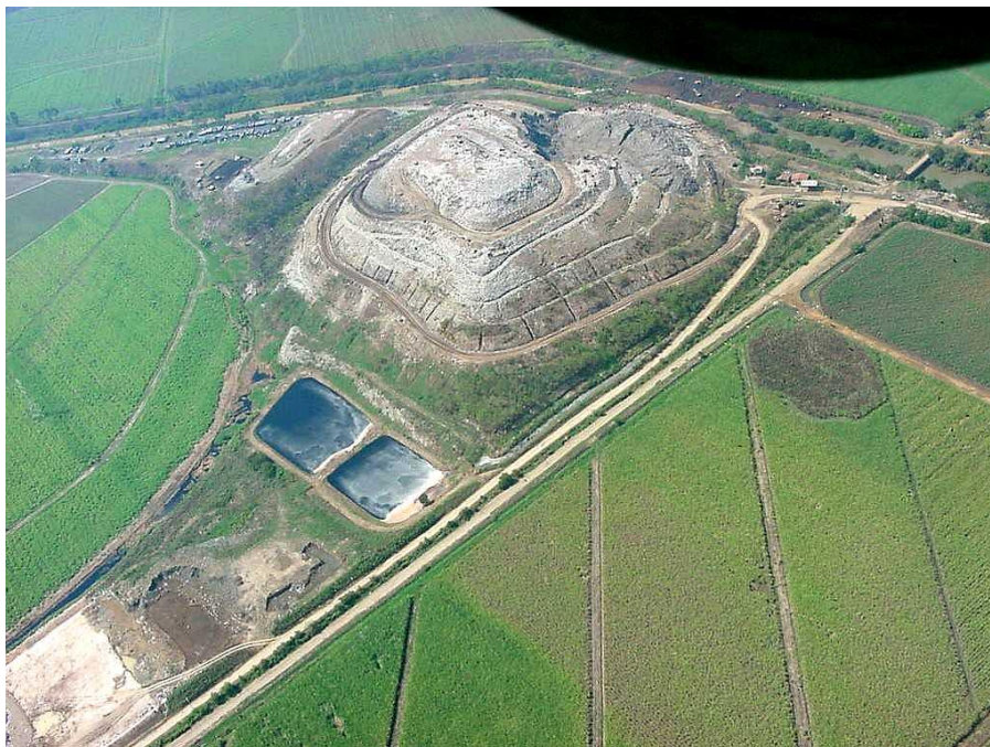
Foto 7.30. Vista aérea de una falla circular de un talud de basura en el relleno sanitario “Navarro” en Cali, Colombia
