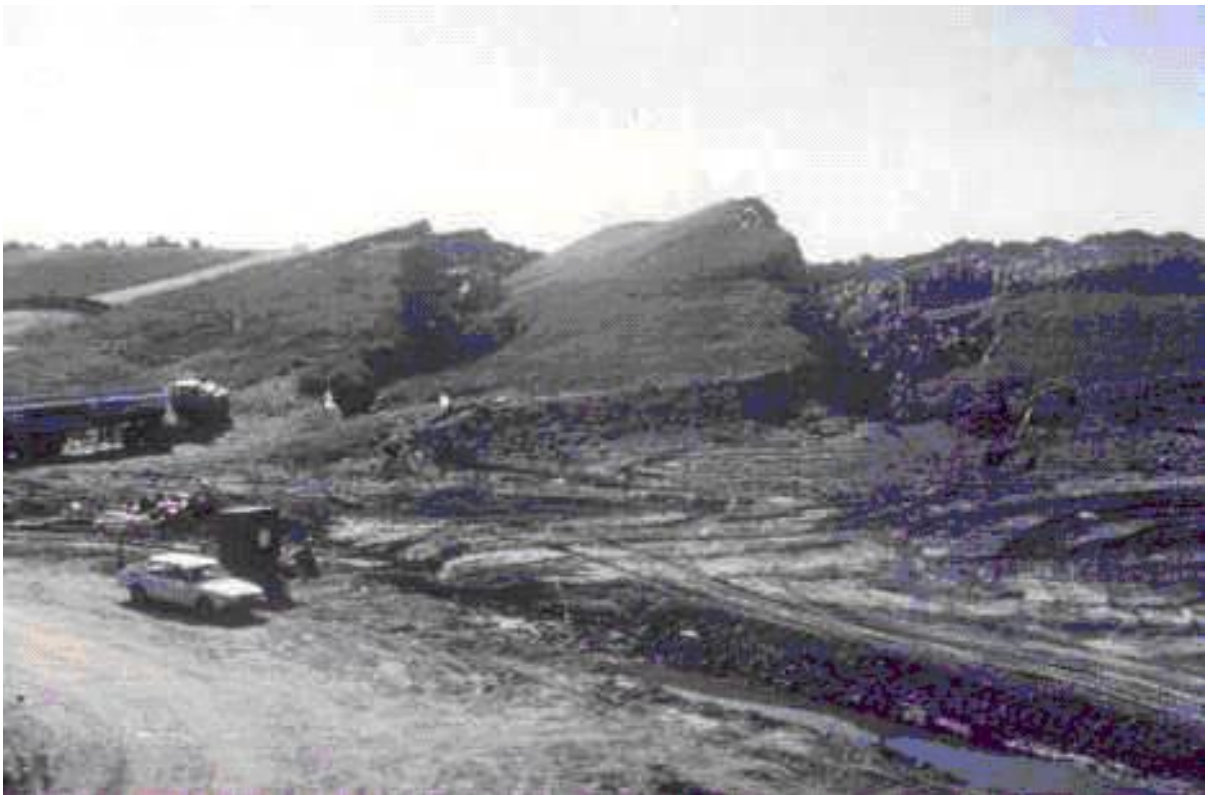
Foto 7.1. Deslizamiento en un relleno sanitario
