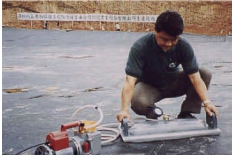
Foto 3.4. Comprobación de soldadura por extrusión
