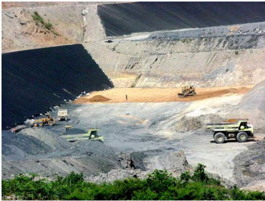
Foto 8.8. Compactación de las capas de Arcilla
