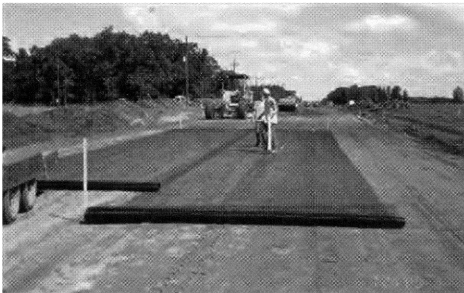
Foto 3.8. Colocación de una Geomalla
