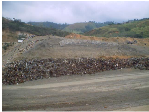
Foto 9.9. Talud de basura con sobrecarga adicional
