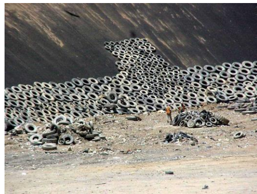
Foto 8.11. Colocación de Cauchos para la Protección de la Geomembrana
