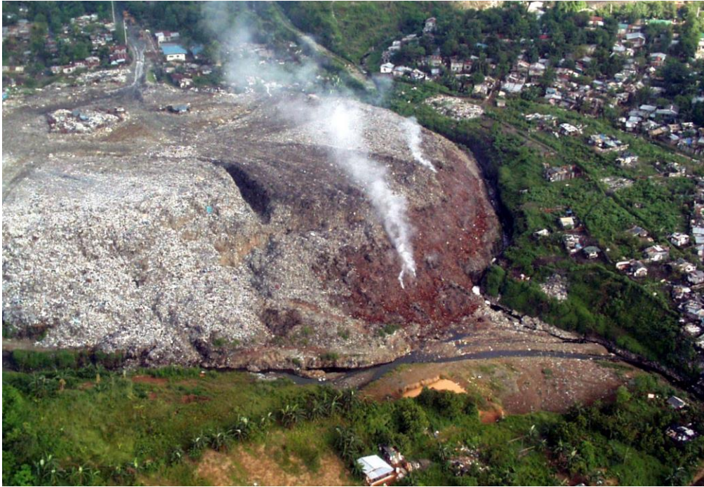
Foto 7.7. Vista del relleno sanitario menor de 5.3 hectáreas mostrando una cárcava profunda excavada desde el área central al borde. Esto evidencia que los desechos son colocados en el tope y caen por la ladera.
