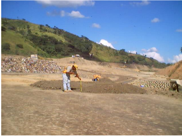
Foto 9.6. Control del espesor de la capa de tierra
