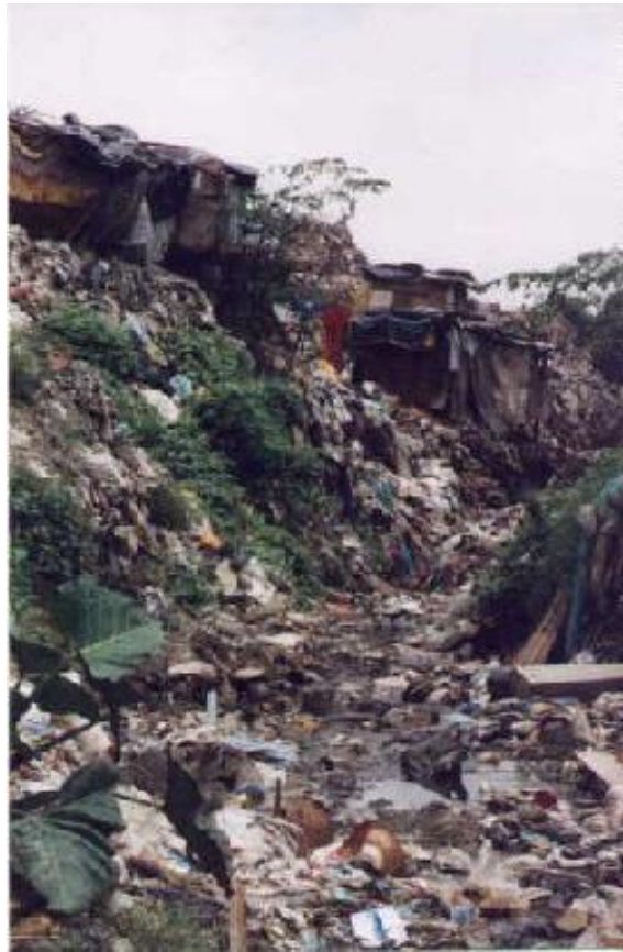
Foto 7.10. Viviendas abandonadas después de ocurrir la tragedia, las cuales no fueron destruidas.
