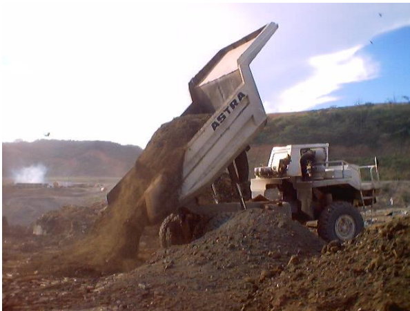
Foto 9.4. Descarga del Material de Préstamo
