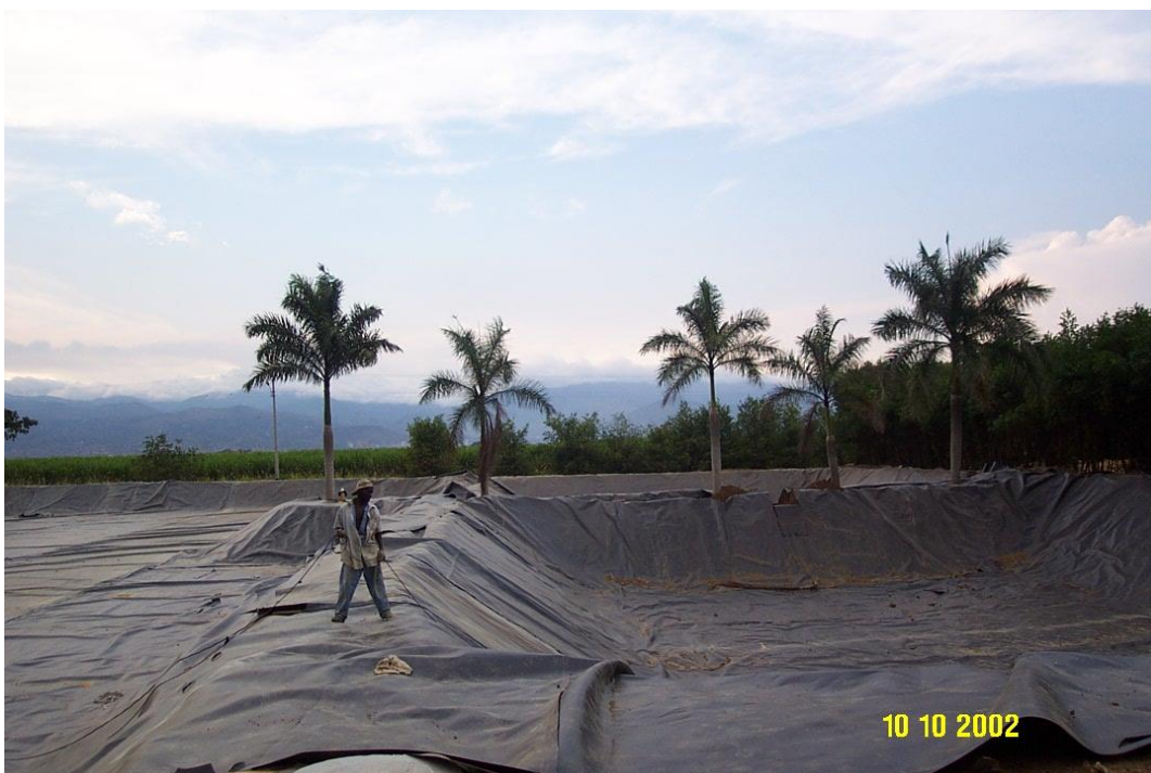
Foto 7.28. Impermeabilización con geomembranas para controlar la contaminación
