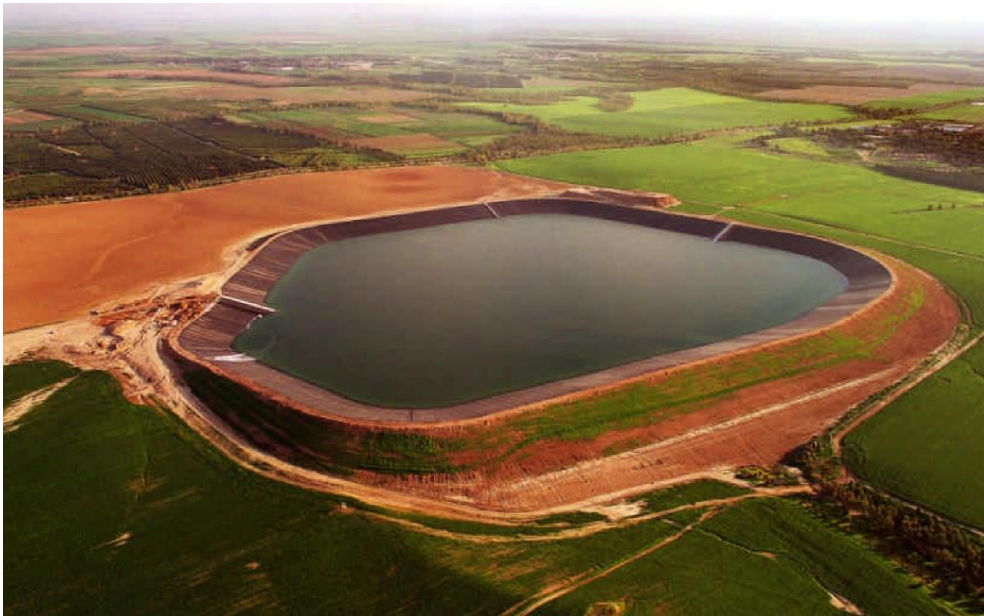
Foto 3.5. Ejemplo del empleo en impermeabilización de estanques
