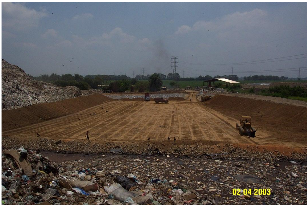
Foto 7.27. Preparación de sitio para convertir el vertedero de basura de Navarro en un relleno sanitario, colocación de capa de arcilla
