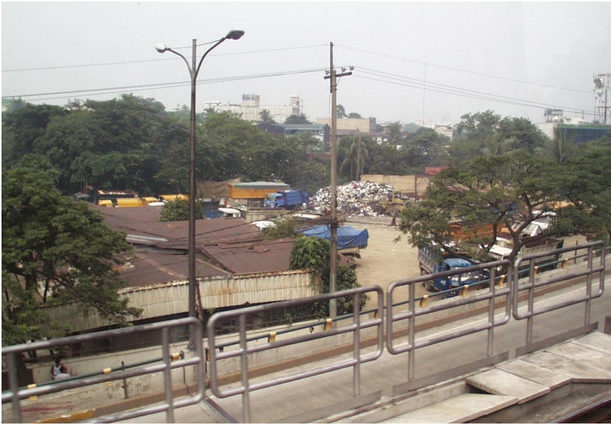
Foto 7.19. Acumulación de desechos sólidos un mes después de ocurrir el deslizamiento. Esta acumulación de desechos que puede verse en la fotografía, es un terreno privado adyacente a la estación de Quezón, perteneciente al sistema de transporte rápido de Manila. Observe también el camión azul recolector de basura, que acaba de descargar unos desechos sólidos.
