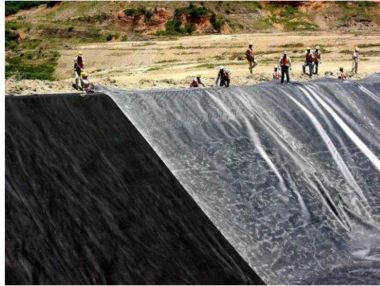
Foto 8.7. Colocación de la geomembrana y Geotextil en el Talud
