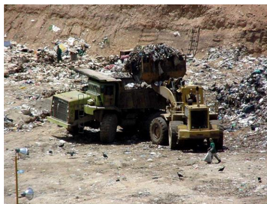
Foto 8.13. Reciclaje, Carga y Acarreo de Residuos Sólidos hacia la Celda
