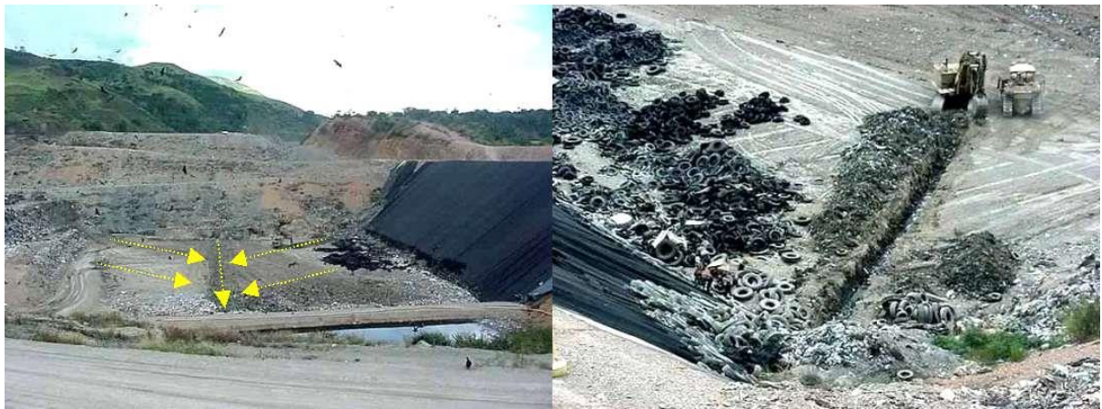
Foto 9.26. Red de trincheras en el fondo de la sub Celda 4 sur
