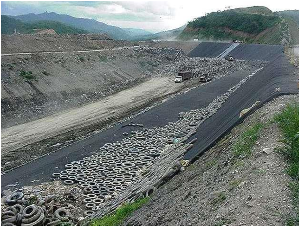
Foto 9.21. Explotación del pasillo entre Recicladores y Celda 4
