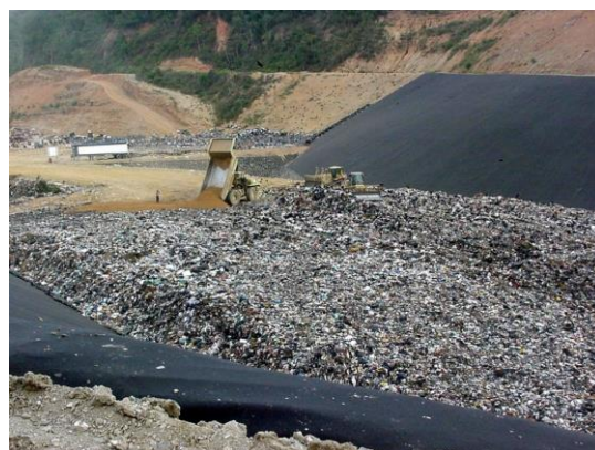
Foto 8.15. Colocación de la Capa de
