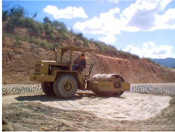
Foto 9.7. Compactación de la sobrecarga adicional
