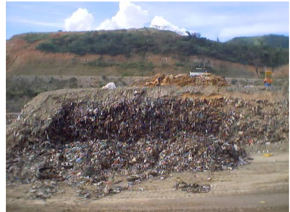
Foto 9.3. Talud de Basura Perfilado con Sobrecarga Inicial
