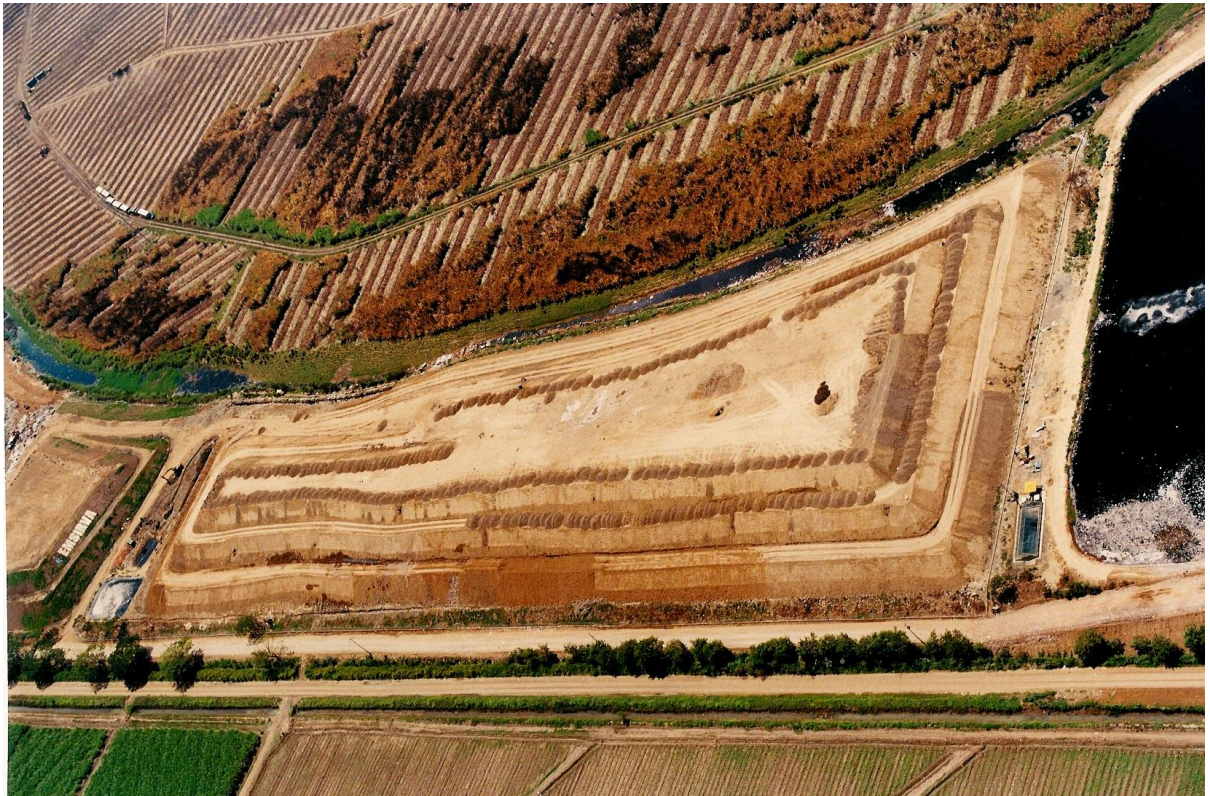
Foto 7.35. Fase constructiva del relleno sanitario adjunto al cerro Navarro
