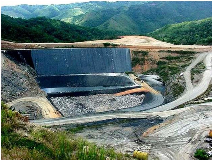
Foto 9.22 Inicio de la explotación en la sub Celda 4 Norte.
