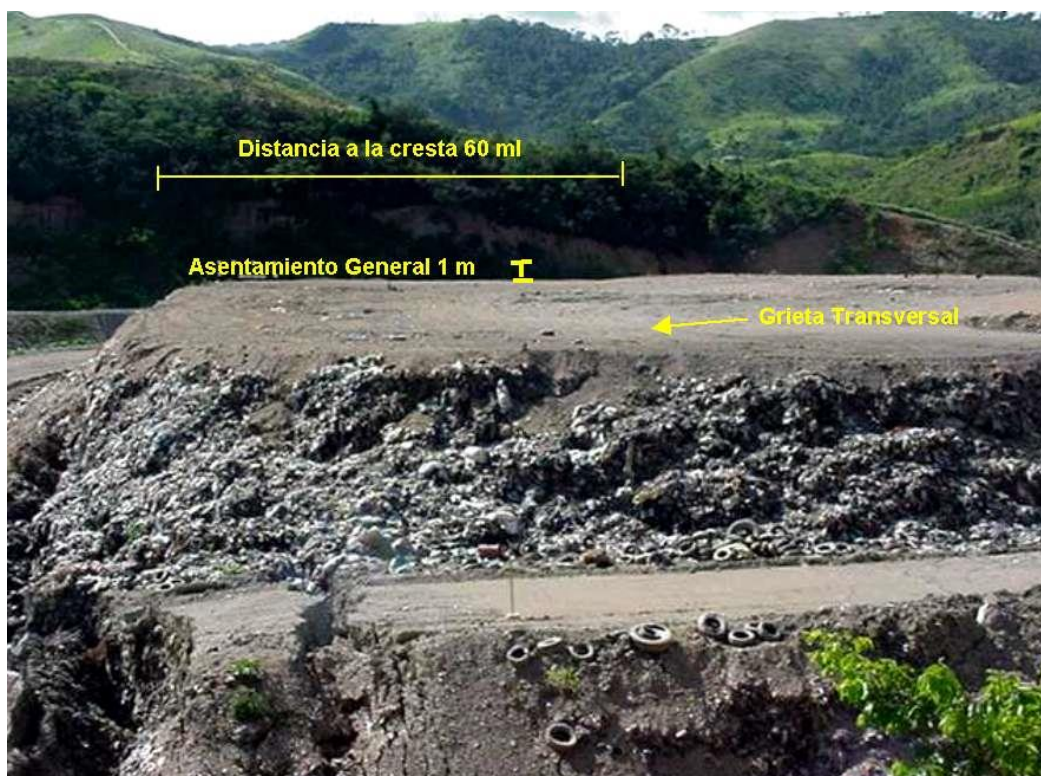
Foto 9.20. Asentamiento general de la masa en movimiento (1 m).
