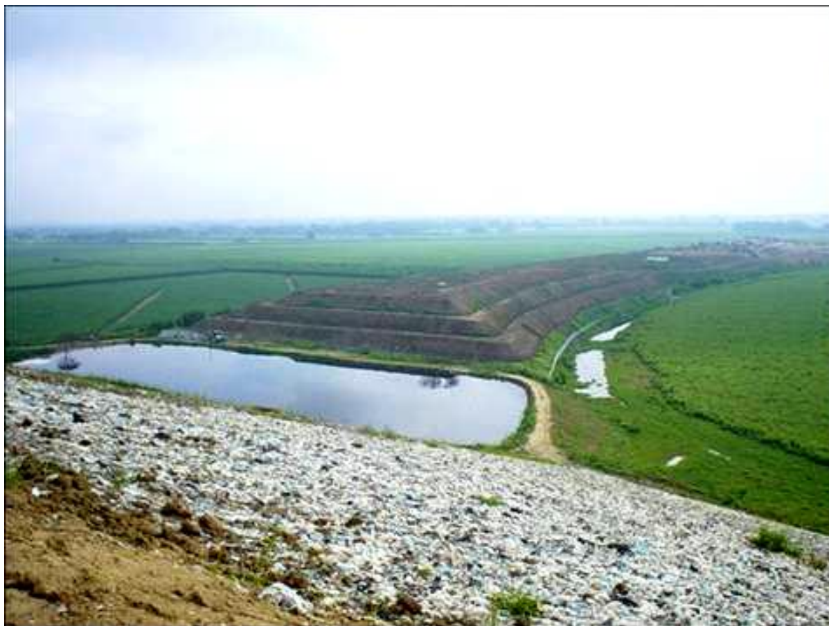
Foto 7.36. Vista lateral del relleno sanitario adjunto al cerro Navarro
