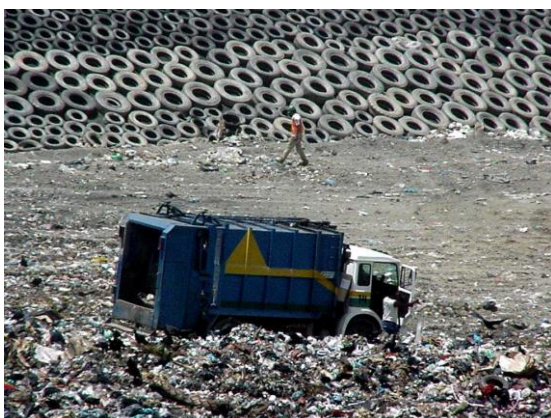
Foto 8.12. Descarga de Residuos Sólidos Directamente en la Celda
