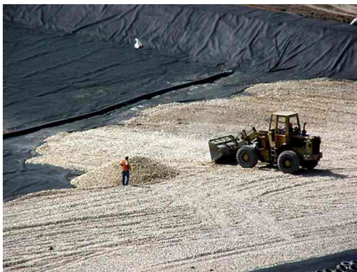
Foto 8.10. Colocación de Capa de Grava
