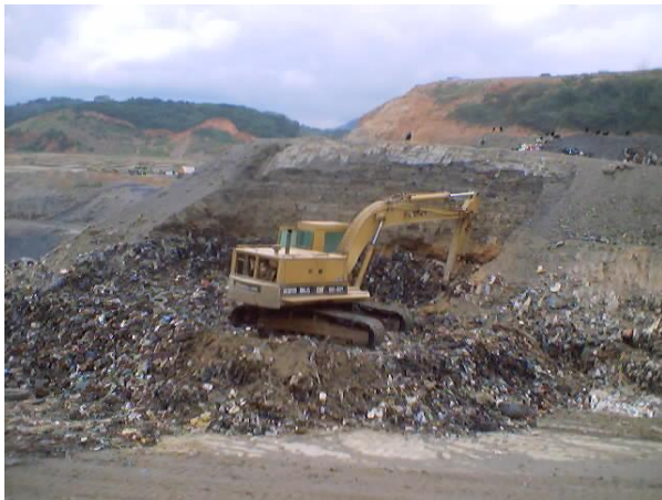
Foto 9.8. Perfilado del talud de basura con sobrecarga adicional
