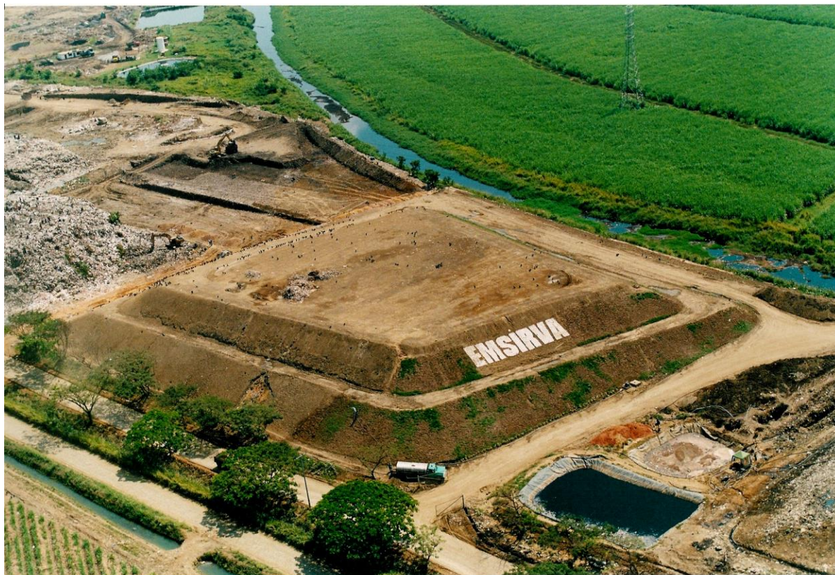
Foto 7.29. Fase constructiva del relleno sanitario
