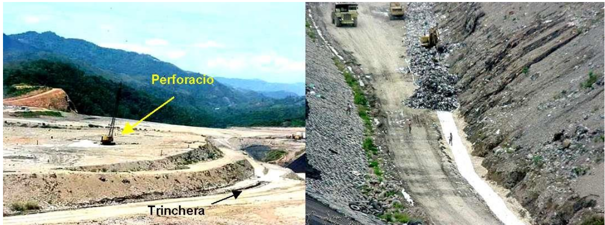
Foto 9.25. En la foto se aprecian parte de las perforaciones, así como algunas de las trincheras implementadas para la extracción de lixiviados
