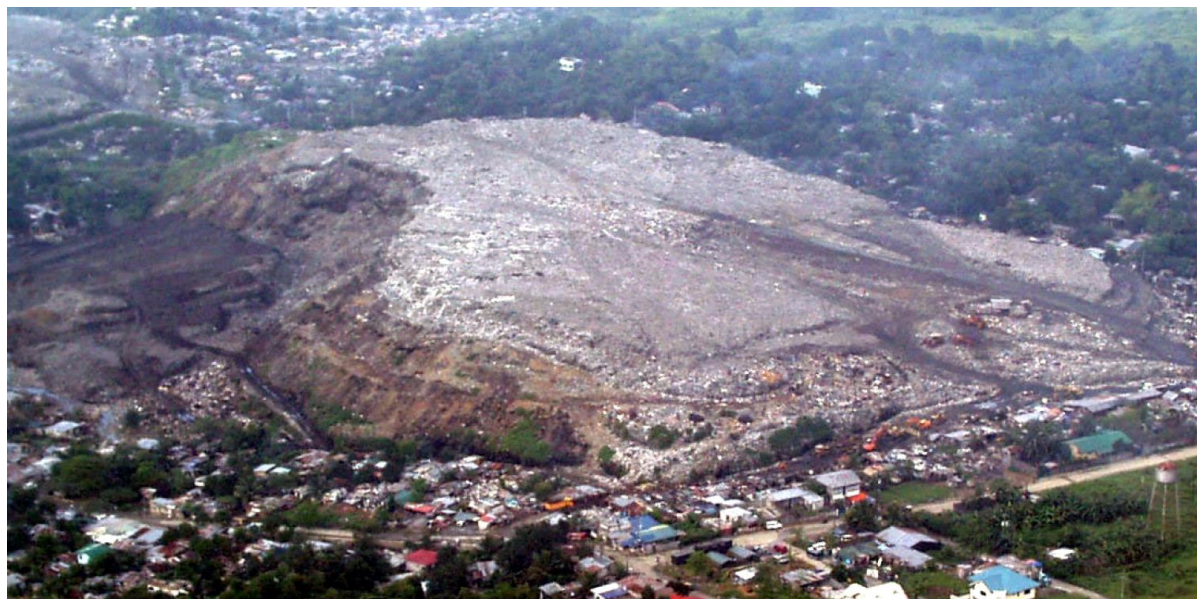
Foto 7.16. Vista aérea del relleno sanitario de Payatas mostrando el deslizamiento en el lado noroeste
