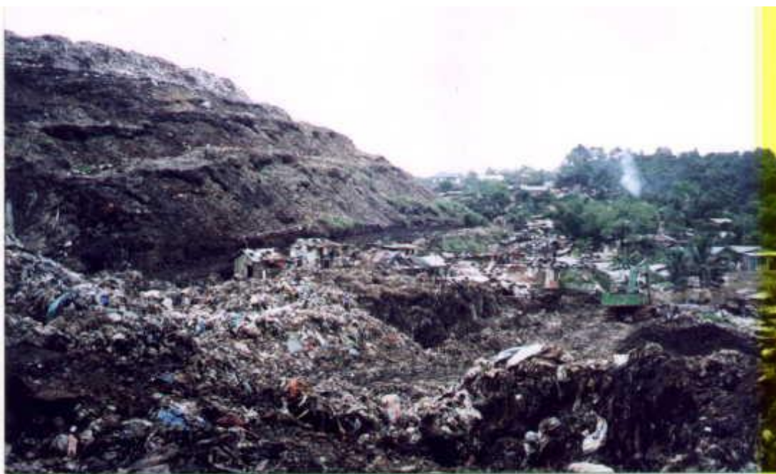
Foto 7.6 Al fondo se observa parte del talud, el cual se mantiene sin fallar. En la parte frontal el deslizamiento de 1,2 millones de metros cúbicos de desechos sólidos, este deslizamiento ocurrió de izquierda a derecha sepultando una gran parte del pueblo. (Angulo derecho).
