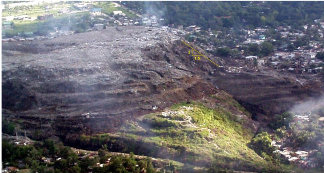
Foto 7.5. Foto de la falla desde un ángulo oblicuo mostrando el talud después de la falla. El talud remanente tiene una inclinación la cual es mostrada con la línea amarilla, la cual es muy cercana a 1V:1.5H.
