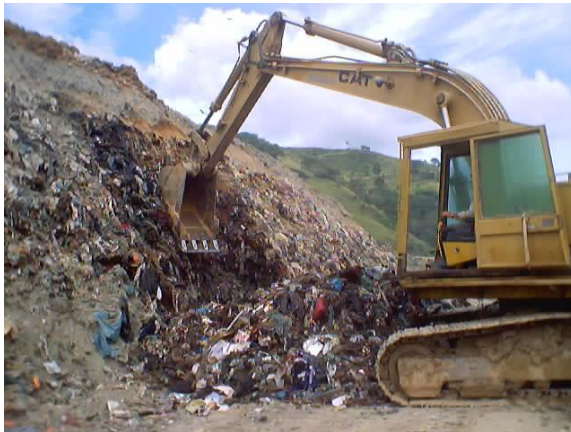
Foto 9.2. Perfilado del Talud de Basura con Sobrecarga Inicial
