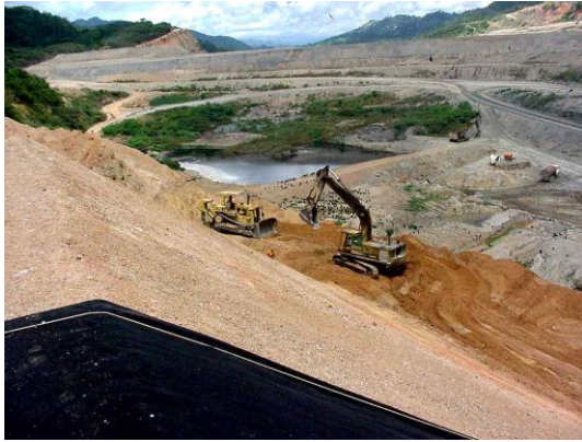
Foto 8.6. Perfilado del talud
