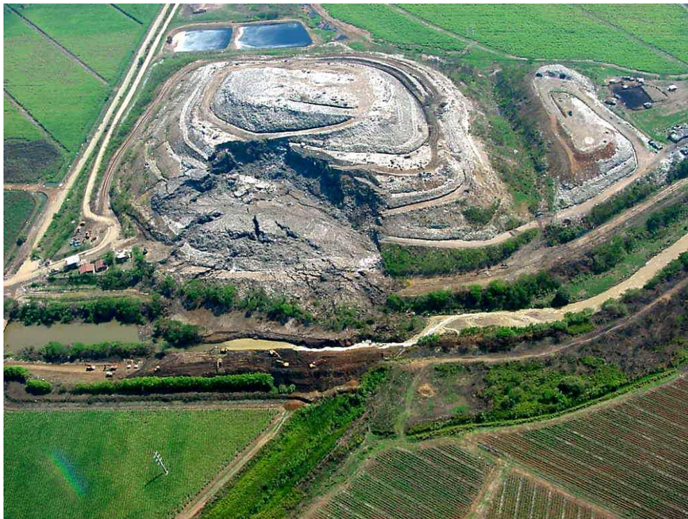
Foto 7.32. Vista aérea de una falla circular de un talud de basura en el relleno sanitario “Navarro” en Cali, Colombia
