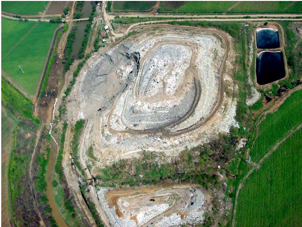
Foto 7.33. Vista aérea de una falla circular de un talud de basura en el relleno sanitario “Navarro” en Cali, Colombia
