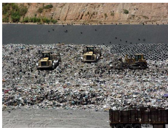
Foto 8.14. Esparcimiento y Compactación de
