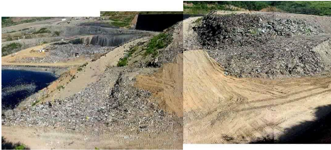
Foto 9.23. Perfilado del talud y sellado de las grietas.
