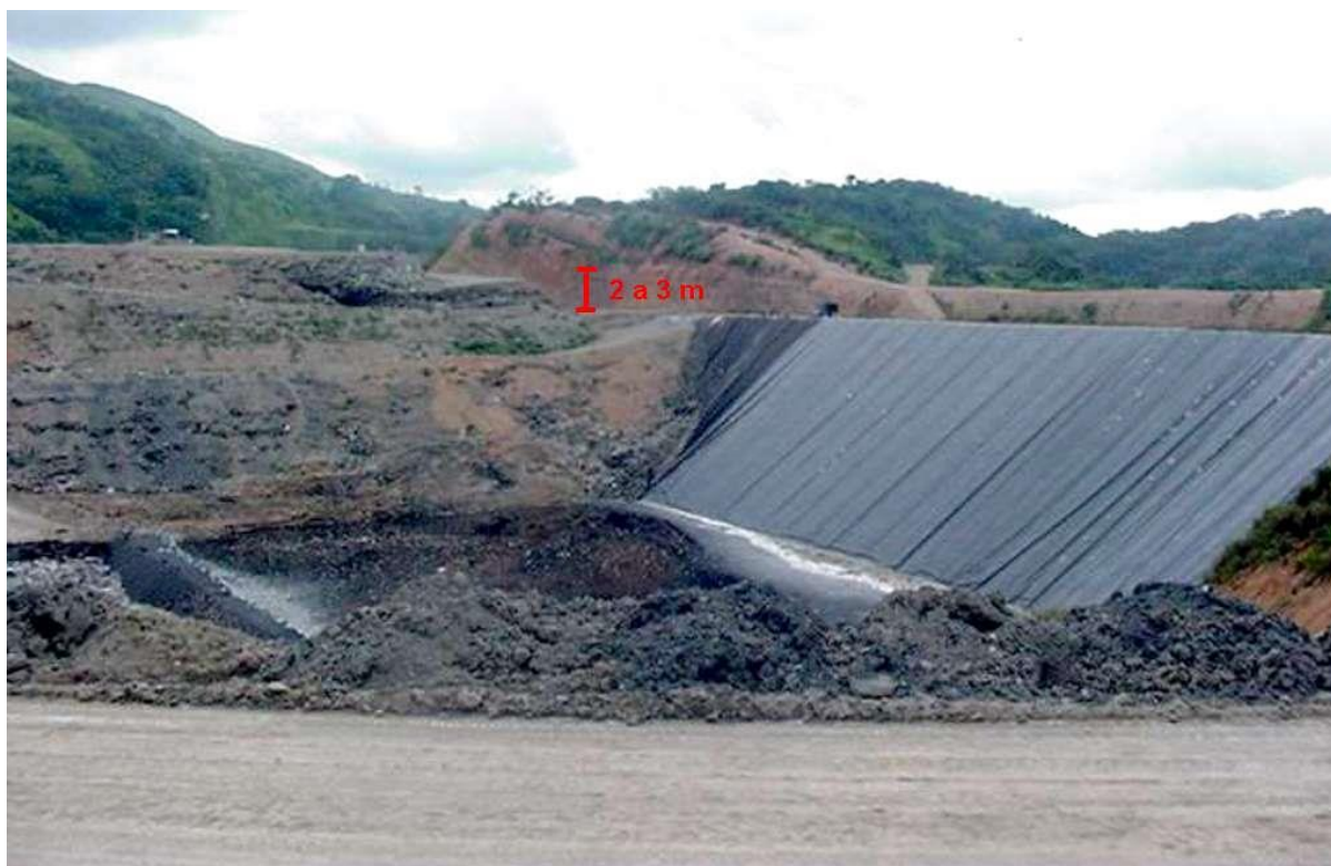
Foto 9.18. Asentamiento del material desplazado (de 2 a 3 metros), (Agosto 2002).
