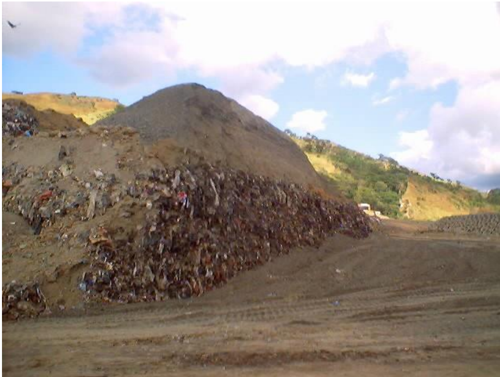
Foto 9.11. Efecto reforzador del plástico en el talud
