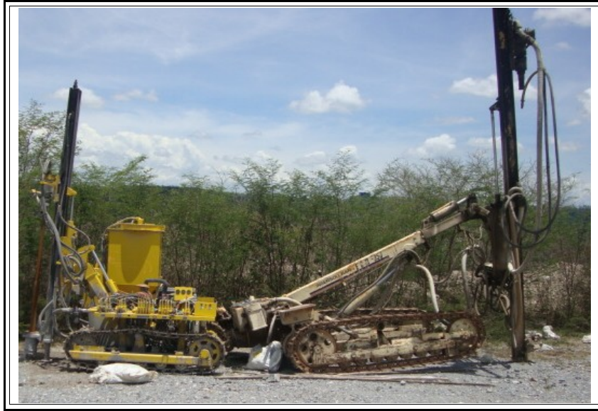
Figura 3.4: Perforadora marca Kaishan Fuente: Elaboración propia.
