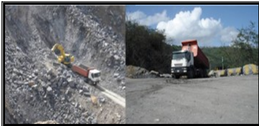
Figura 3.5: Carga y acarreo del material a la planta de trituración Fuente: Elaboración propia.
