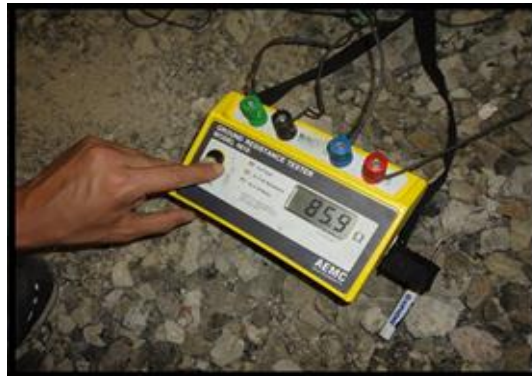
Figura 6.1.2 Medición de resistencia en sótano del teatro, con equipo AEMC, modelo 4610.
