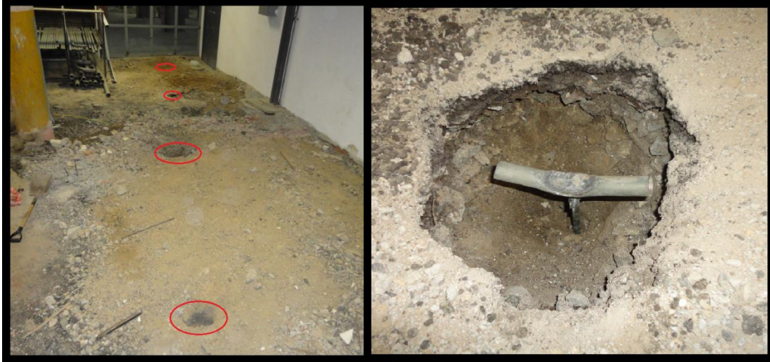
Figura 6.1.1.1 Perforación de suelo para inserción de electrodos de medición
