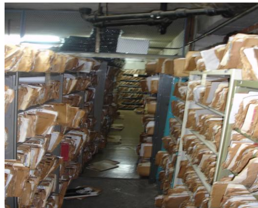
Foto 14. Tuberías de aguas negras
