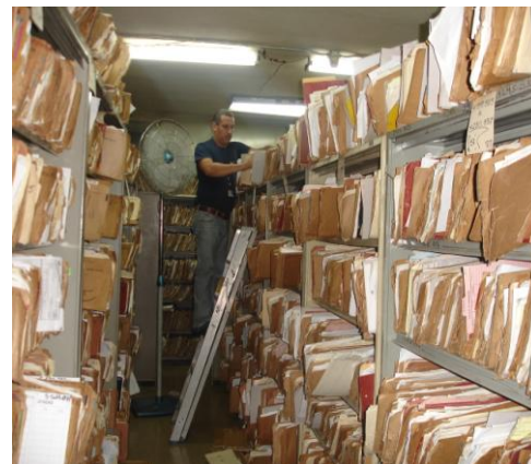
Foto 12. Falta de sistema de ventilación
