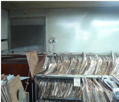
Foto 9. Sistema eléctrico cercano a los expedientes
