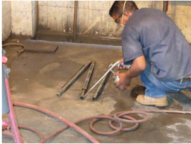
Figura 3-6. Detalle de la limpieza con Thinner.
