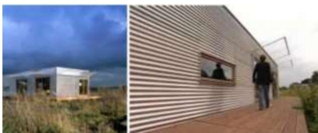
Figura 9: Sistema M House de láminas de aluminio (Web: [www.m-house.org](http://www.m-house.org))
