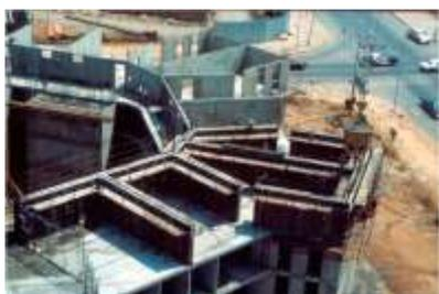
Figura 8: Sistema de paredes portantes Simix (fuente propia)
