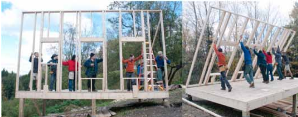
Figura 8. Autoconstrucción de una vivienda con madera
