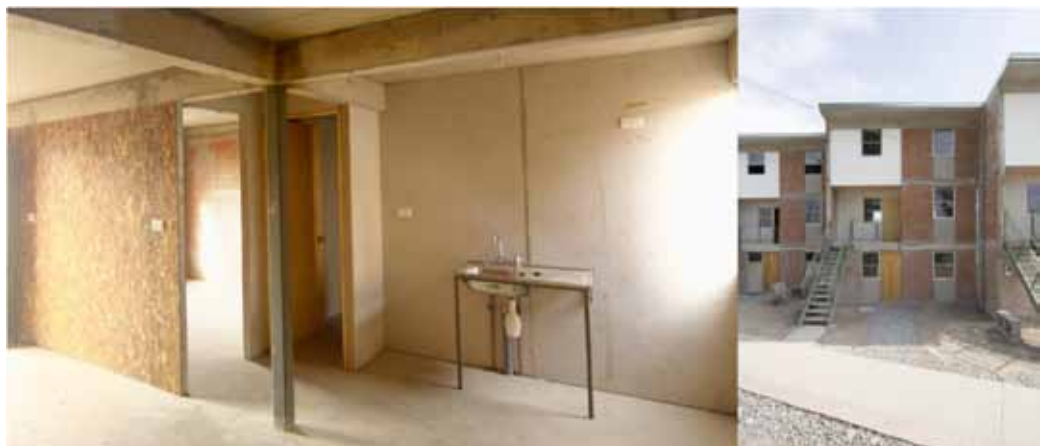
Figura 3. Paneles de madera como cerramiento interno. Proyecto de Vivienda Lo Espejo, Chile
