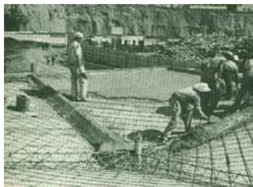
Figura 9. Prototipo de paraguas invertidos de Tecamachalco en México, D.F.
