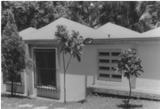
Figura 24. Techos de paraboloides hiperbólicos de la casa de la familia Coll para el año 1963.
