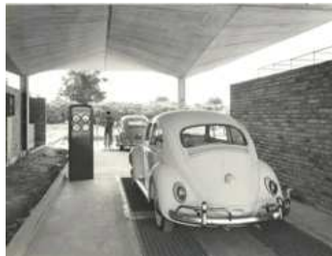
Figura 31. Paraguas invertidos de la Planta ensambladora Volkswagen. Fuente: ebay-venezuela.tumblr.com
