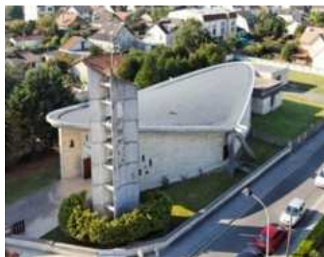
Figura 4. Cubierta de paraboloides hiperbólicos iglesia de Notre Dame de la Paix.
