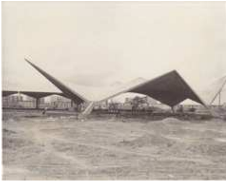
Figura 28. Construcción de paraboloides hiperbólicos del Colegio de Médicos del Zulia. Fuente: Archivo del Arq. Coto Asenjo. Cortesía de Arq a Carolina Coto.
