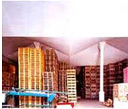
Figura 5. Estado actual de los primeros paraguas de paraboloides hiperbólicos construidos, en Europa, por el ingeniero Giorgio Baroni.
