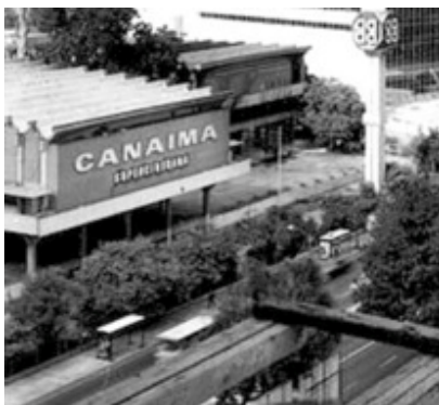
Figura 26. Techos de paraboloides hiperbólicos del Cine Canaima.
