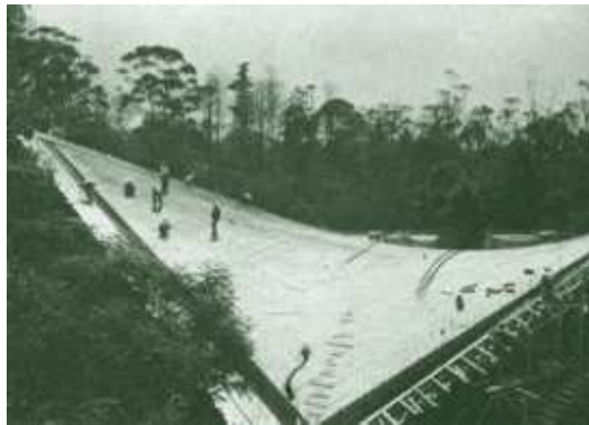
Figura 17. Capilla del Altillo una vez vaciada la cubierta.
