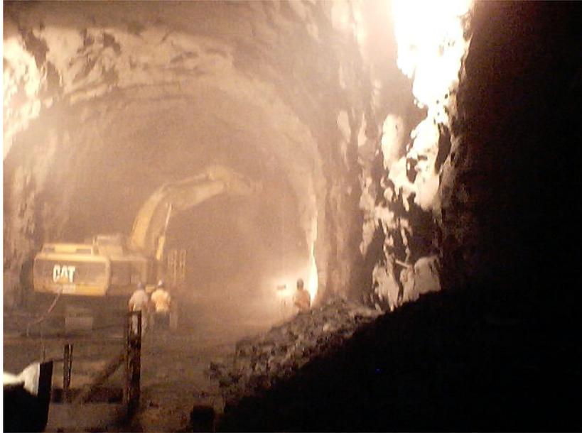
Anexo 14 Preparación de frente para perforación de barrenos.
