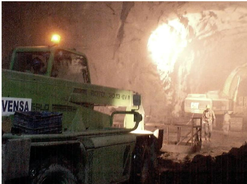
Anexo 13 Roca competente autoportante excavación con voladura.
