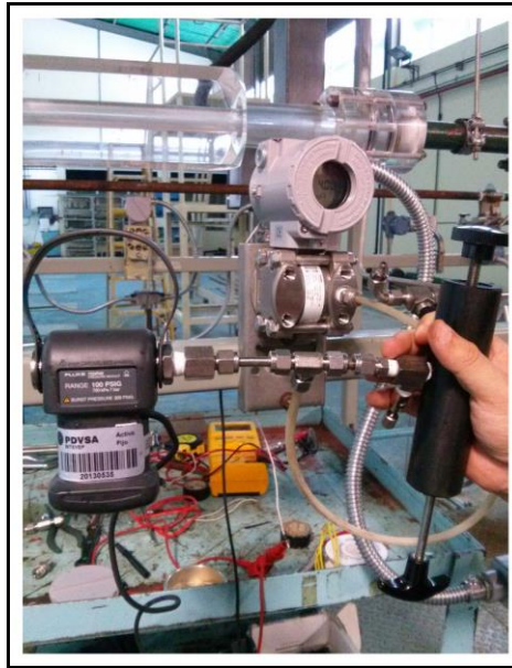
Figura N° 17 Conexión de un transmisor e indicador de presión diferencial con su respectivo módulo de presión.
