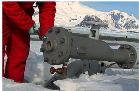
(b) Lanzador con brida ciega
