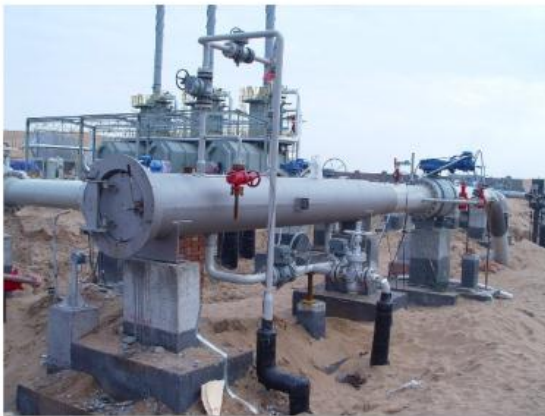
(a) Lanzador de compuerta con seguro
