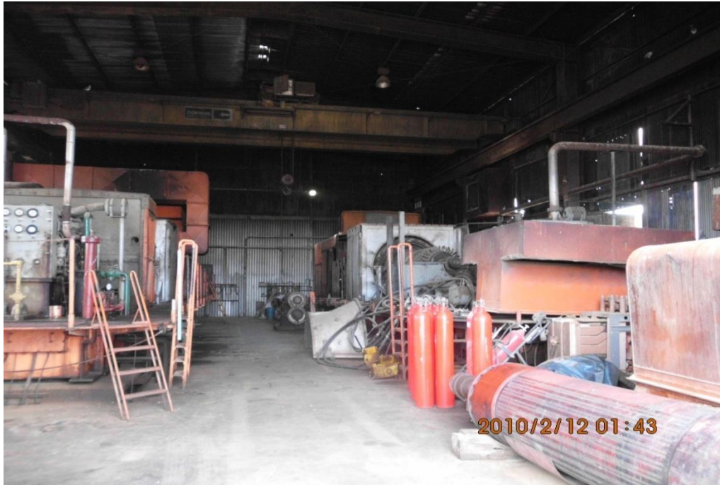
Figura N°7 Condición del galpón a utilizar para la instalación de las unidades turbogenerador
