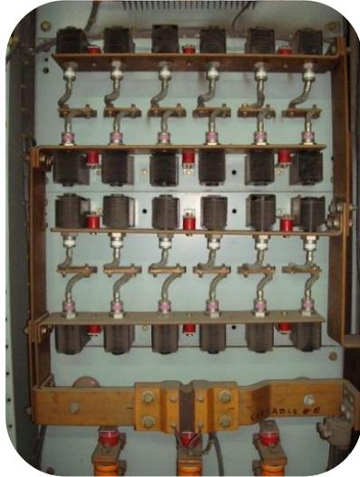
Foto. 53. Punte rectificador. (Diodos).
