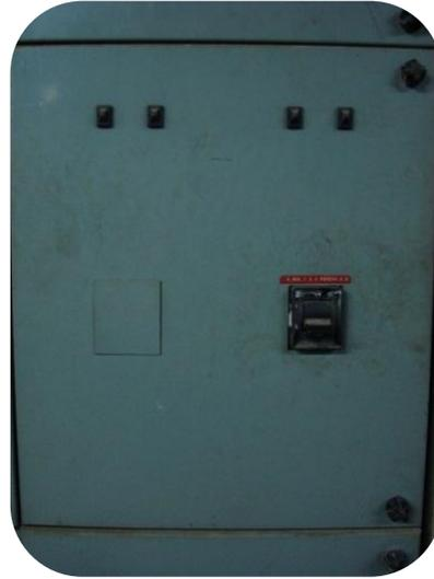
Foto. 57. Gabinete asociado al interruptor del circuito que alimenta el motor del banco T.F.
