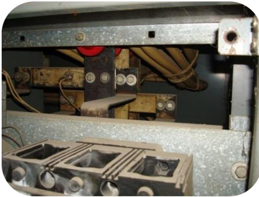
Foto. 58. Sistema de barras empleado para la distribución de energía DC dentro de los gabinetes.
