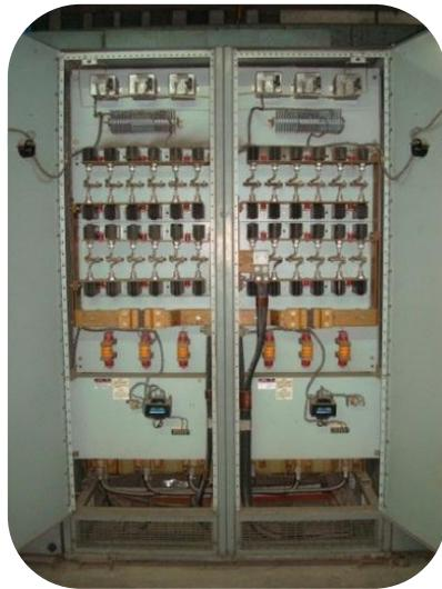
Foto. 51. Conexiones de las unidades rectificadoras.
