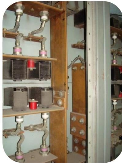
Foto. 52. Barras DC dispuestas a la salida de la unidad rectificadora.
