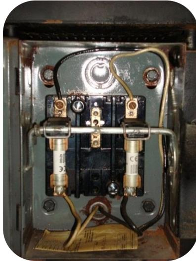
Foto. 66. Parte interna de la fusilera del motor.
