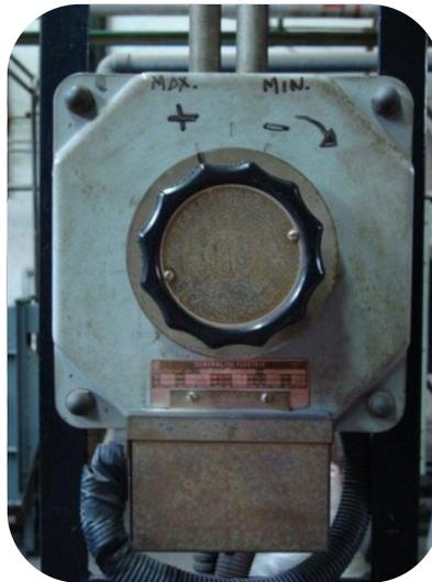
Foto. 81. Regulador de velocidad del motor.
