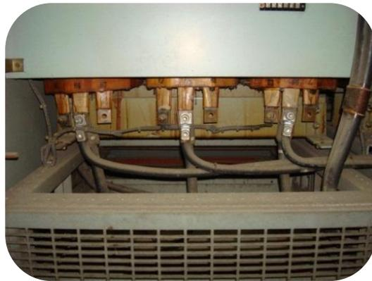
Foto. 55. Conductores y conexión de la alimentación para las unidades rectificadoras.
