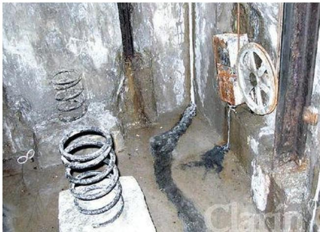
Figura 3.6. Regulador de velocidad y resortes en mal estado [8].
