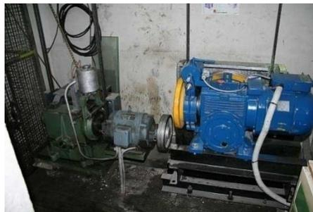
Figura 3.12. Motores jaula de ardilla de dos velocidades [8].
