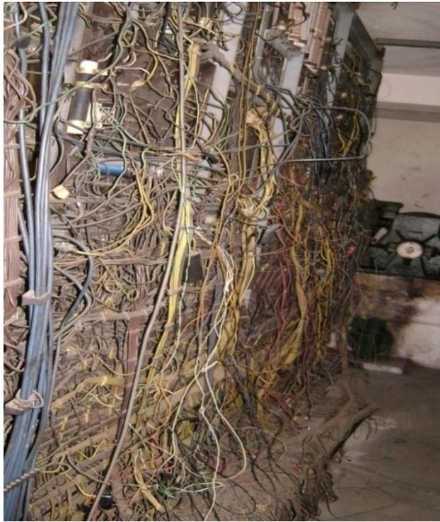
Figura 3.2. Cableado de un Sistema de Control, parte posterior en mal estado [8].
