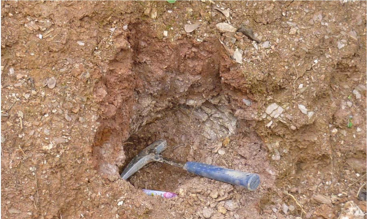
Figura 1.2. Excavación de 30 cm de profundidad en un talud representado por flujo de detrito.
