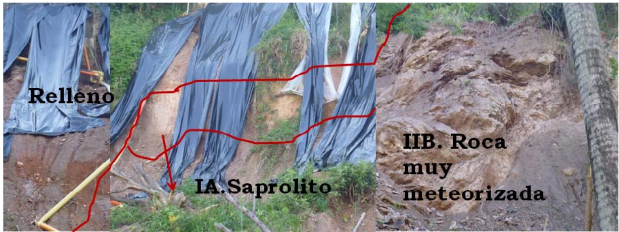
Figura 4.4. Vista en campo de los horizontes I y II donde reflejan cambios del comportamiento del talud y variaciones en la litología que permiten describir e identificar el tipo de perfil de meteorización presente.
