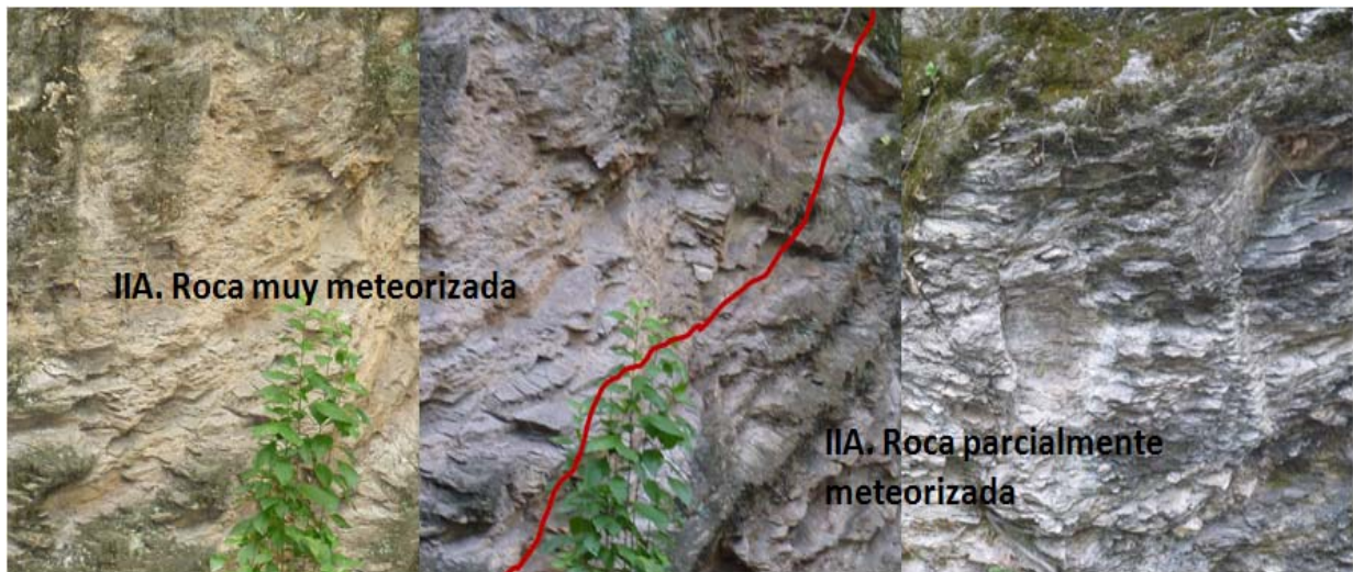
Figura 4.6. Detalle del talud ubicado en Colinas de San Román subiendo por la calle Buenaire, el cual se muestra los rasgos característicos del horizonte II, hacia la parte izquierda se muestra una roca decolorada color anaranjado claro meteorizada, mientras que del lado derecho el color cambia a gris oscuro.
