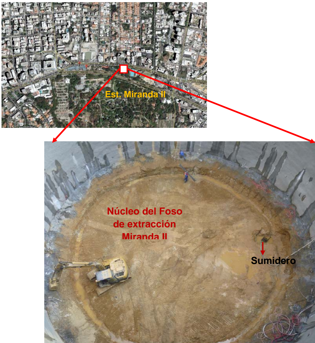
Figura 4.24. Vista en planta del foso de extracción Miranda II, a una profundidad de 23 metros, se observa un jumbo limpiando la zona, removiendo la tierra, material acumulado del concreto entre otros. Nótese la acumulación de agua producto a presencia del nivel freático, la cual se extraía mediante los sumideros.
