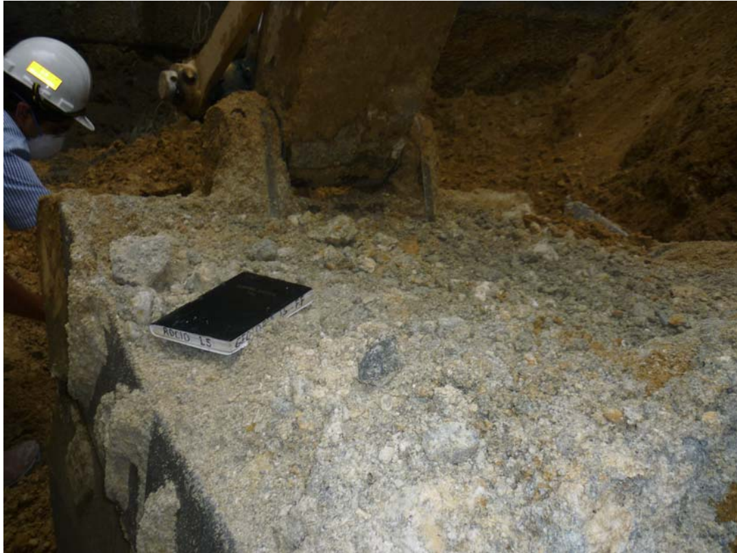
Figura 4.33. La imagen muestra una pala de jumbo con material clasificado como grava arenosa color gris a blanco, se puede notar los tamaños de grano grueso de la arena y los cantos redondeados, algunos fragmentos de esquistos sub-angulares, meteorizados.
