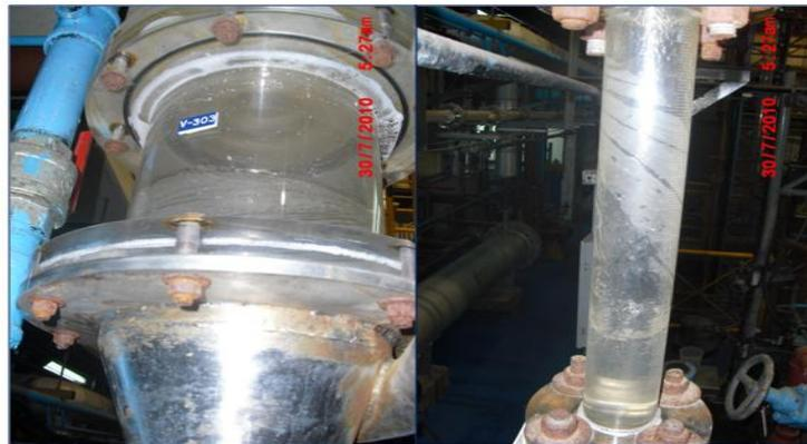
**Figura N° 31: Trampa de líquido en presencia de arrastre de líquido.**
