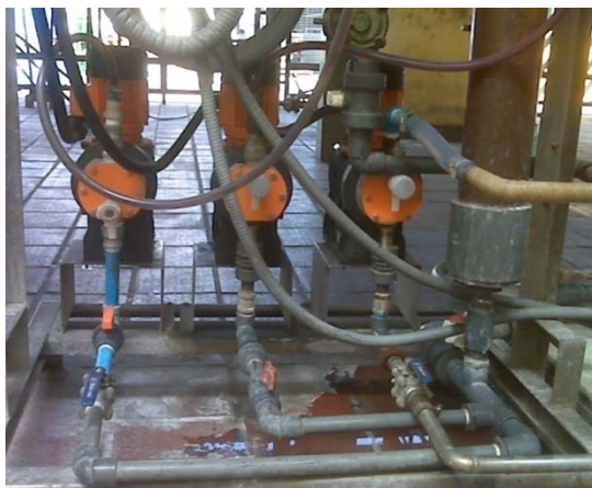
Figura A- 6. Instalación bombas de dosificación.
