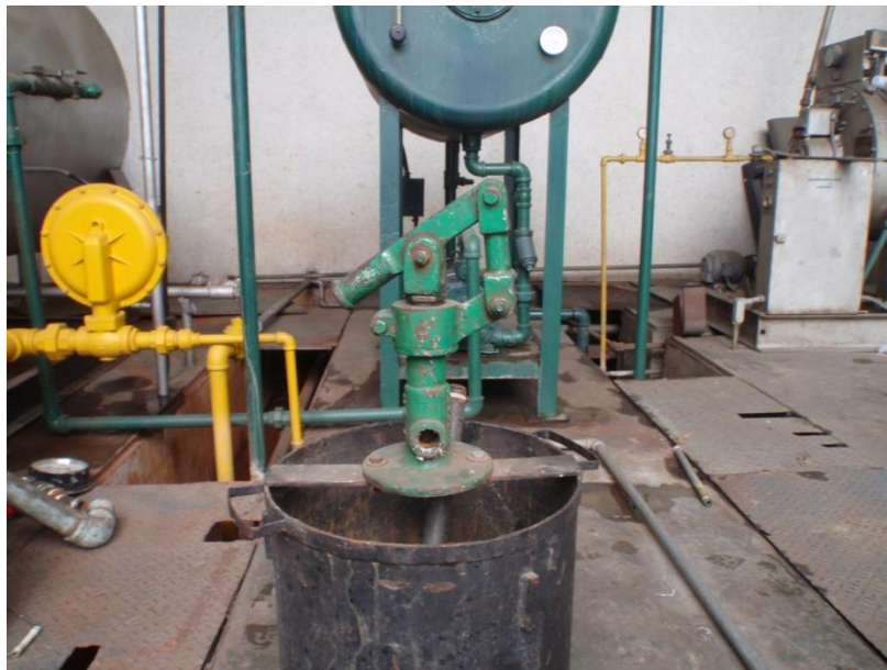
Figura N° 15. Bomba manual tipo pistón .
