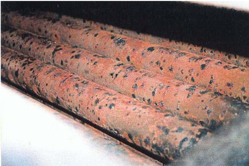
Figura N° 2. Corrosión por oxígeno o "pitting" (Shield, 1982).
