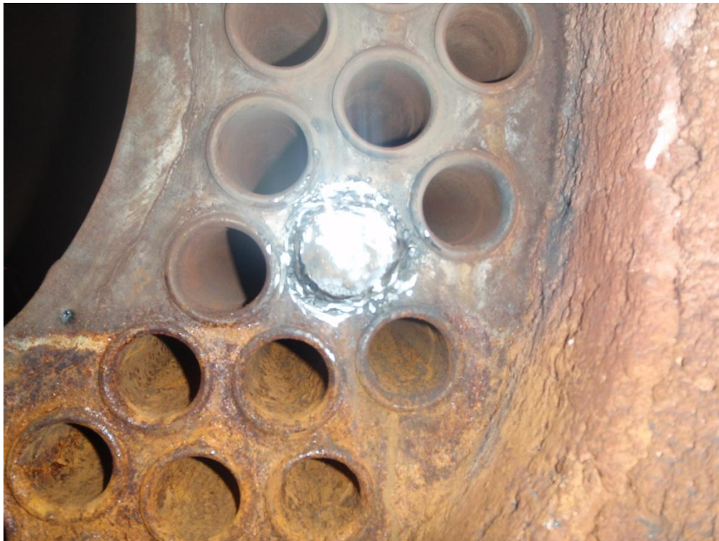
Figura N° 9. Trabajo de reparacion en tuberias.
