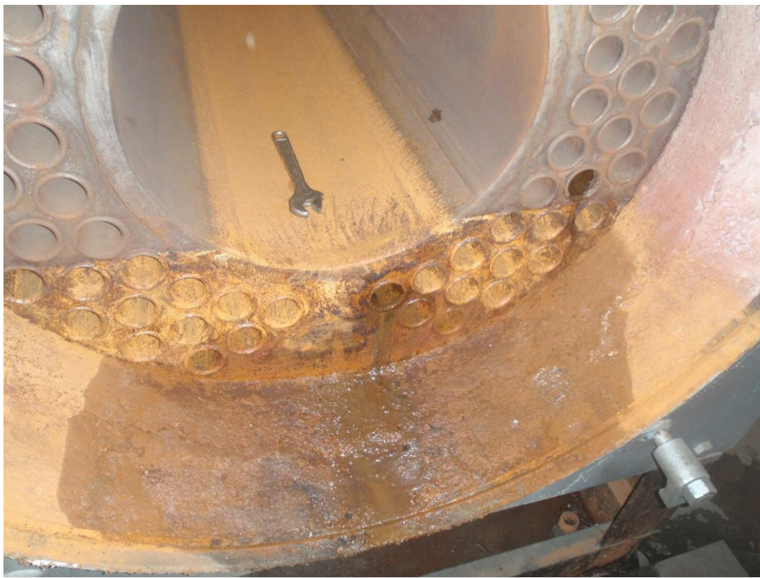
Figura N° 7. Tubos fisurados de la caldera
