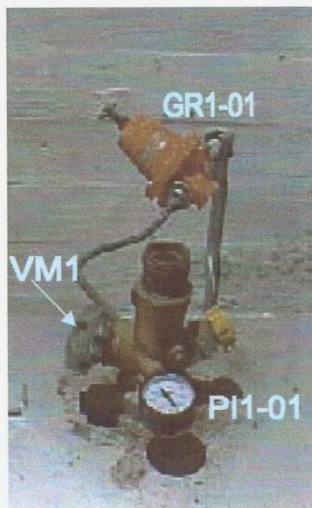
FIG.11.B. Sistema de Salida del Tanque de Combustible
