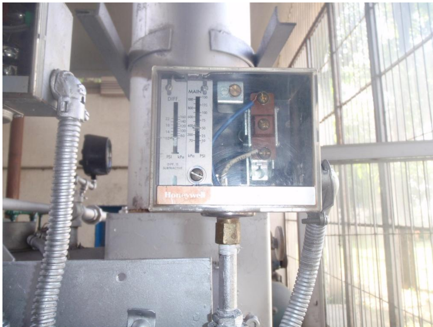
Figura N° 19 Presostato accionado por micro switch
