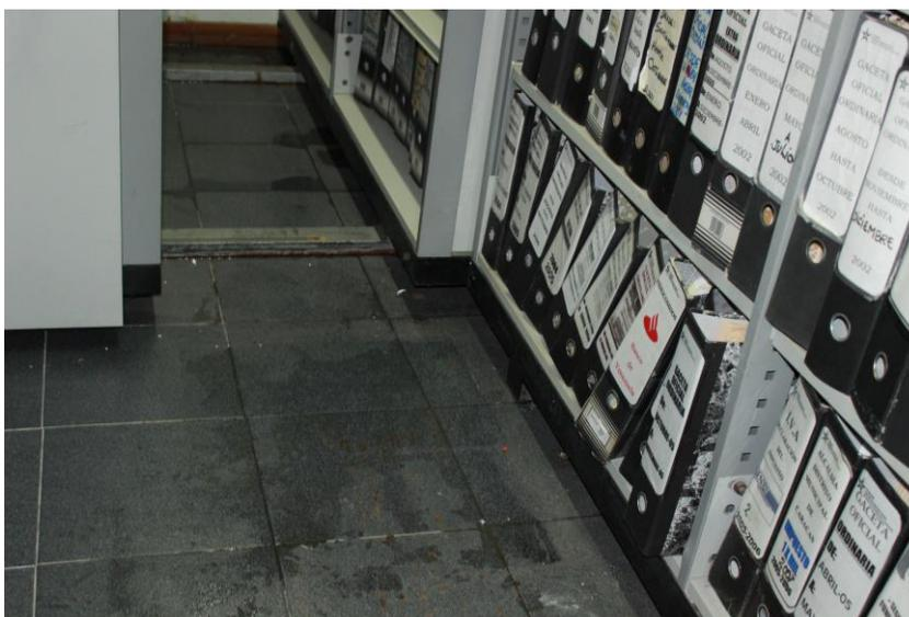
**Figura 6: Filtraciones de agua en el suelo del depósito de archivos**
