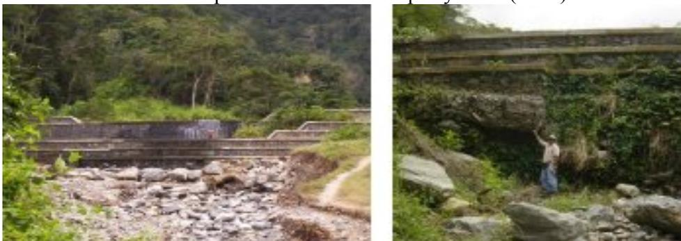
**Figura 2.-** Vista desde aguas abajo de la Presa # 2 en quebrada Piedra Azul. Foto izquierda tomada en Marzo 2005 y foto derecha en Abril 2007, observándose un descenso del lecho de unos 3m aproximadamente al pie del contradique. Tomado de López y otros (2007).
