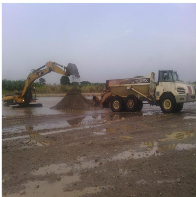
Normalmente, se realizan excavaciones en forma de piscinas construidas perpendicularmente a la dirección del cauce del río. De esta manera, en épocas de lluvia se llenan de rocas y sedimentos que arrastran las crecientes. La construcción de estas piscinas es innecesaria en caso de que el tramo del río destinado a la extracción de áridos presente curvas pronunciadas, en donde se generará acumulación de áridos de manera natural impulsada por el propio medio fluvial.
