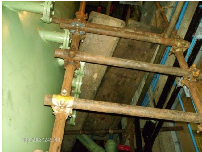
Figura 52. Andamios colocados para la Toma de las Muestras de Resinas.
