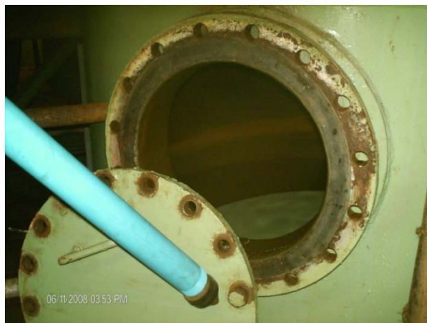
Figura 55. Boca de Visita del Intercambiador Aniónico Débil.
