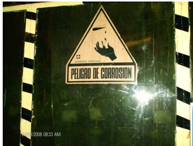
Figura 44. Señalización de Seguridad en la Estación de Dilución.
