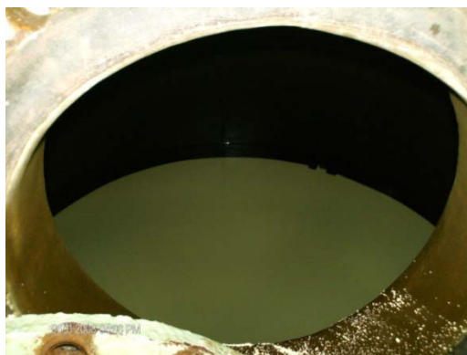
Apertura del Acceso por el tope del Intercambiador Aniónico Débil A1.
