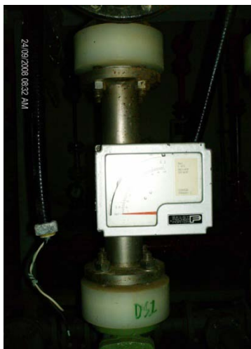
Figura 46. Modelo de Rotámetro empleado en la Estación de Dilución.
