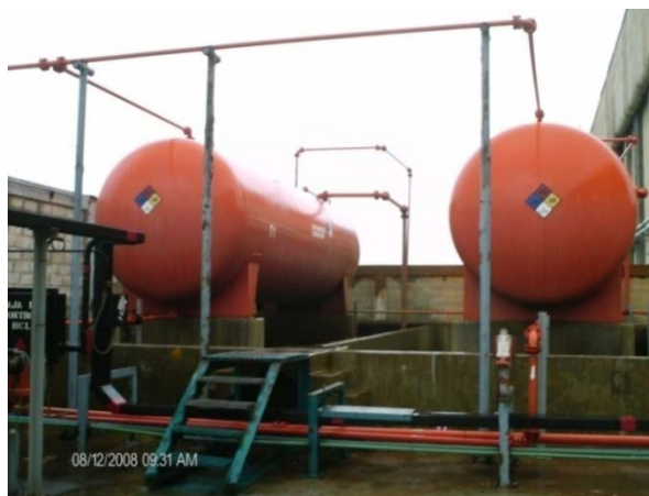
Figura 39. Tanques de Ácido Clorhídrico.
