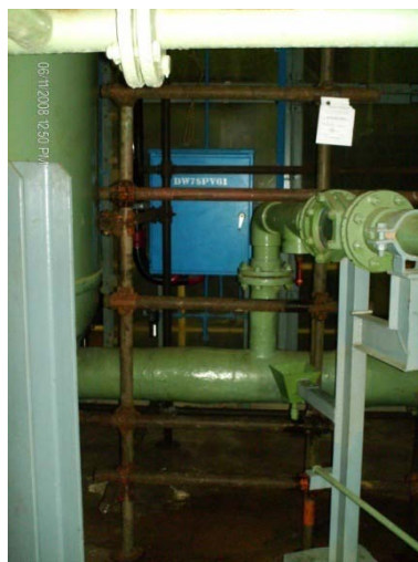
Figura 51. Andamios colocados para la Toma de las Muestras de Resinas-
