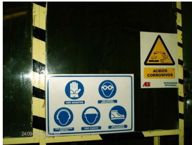
Figura 43. Señalización de Seguridad en la Estación de Dilución de los Regenerantes.
