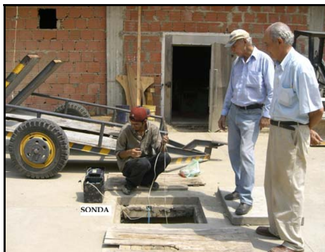
Figura 3.- Medición con la sonda eléctrica de los niveles estáticos.
