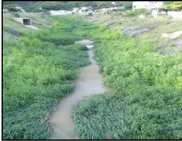
Figura 12. Canal del río Macuto revestido con gaviones. Vista aguas abajo de la presa Macuto.
