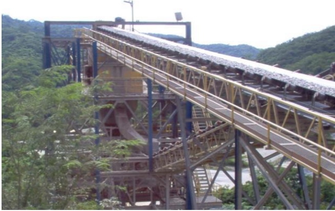
Figura 2.16.- Cinta transportadora en funcionamiento, cantera El Melero. Fuente: Presentación de Operaciones Mineras, Piña Aurora, 2011.
