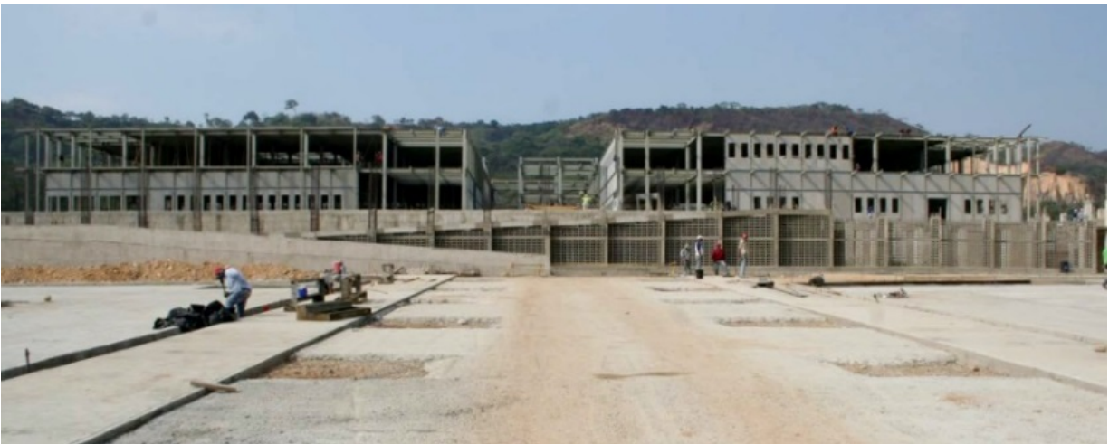
Figura 6: Hospital Toxicológico y Oncológico de Barinas, en obras. Fuente: SCHULTZ, Edzard (2013)
