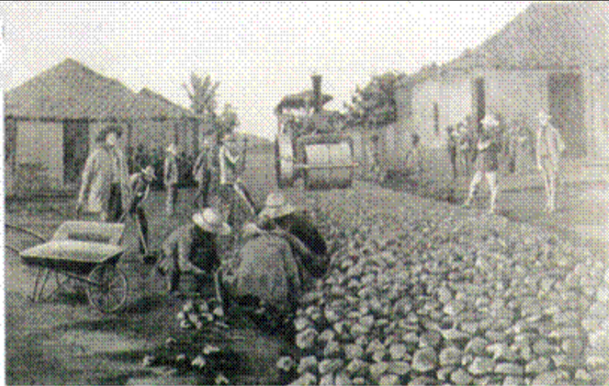
Con la técnica de Telford-MacAdam se realizó la construcción de carreteras venezolanas en las primeras décadas del siglo XX. Tomado de: Eduardo Arcila Farías. Historia de la ingeniería en Venezuela .
