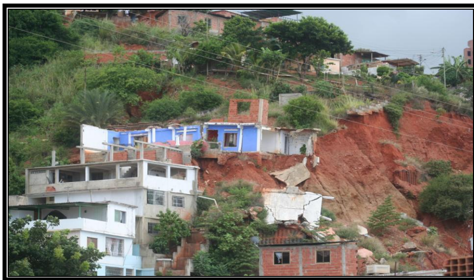
Anexo 5: La inestabilidad de los terrenos es una limitante para el desarrollo habitacional(Foto Solanghy Arcaya)
