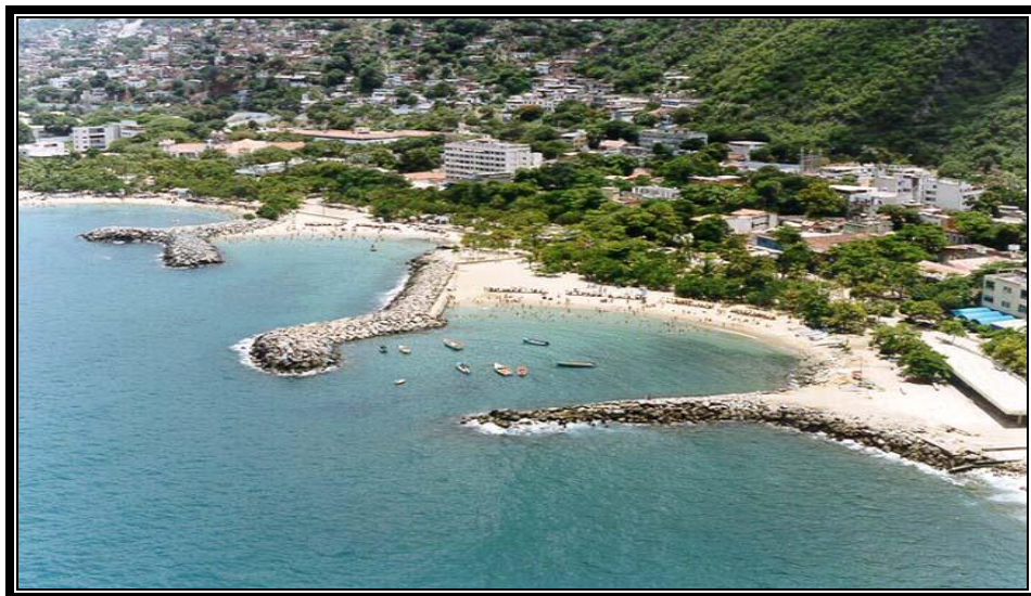
Anexo 6: Antes de la tragedia del 99 las costas contaban con una infraestructura turística en pleno desarrollo(Foto:Gobernación del estado Vargas)
