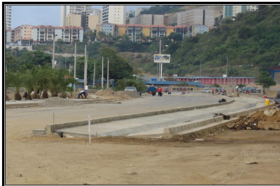
Foto 18: La construcción de la nueva vía en el borde costero surge como alternativa con proyección turística (Foto Solanghy Arcaya)
