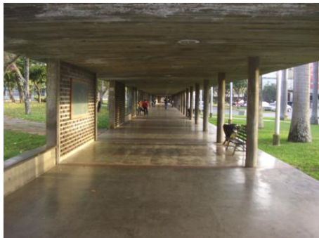
Pasillo Cubierto de Medicina Exp.
