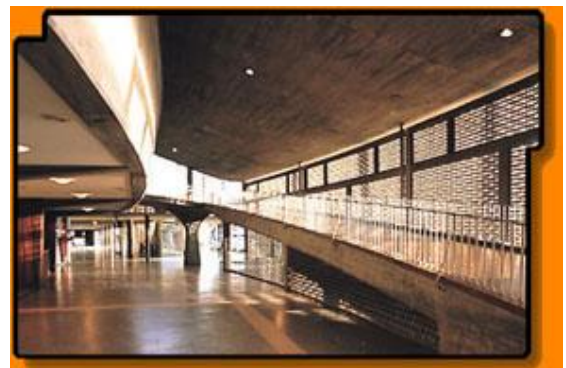
Rampa de acceso al Aula Magna
