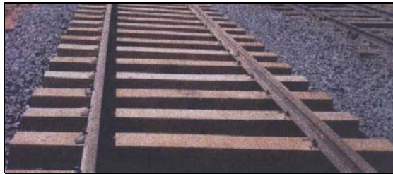
Fig. 4.8: Vía férrea con durmientes de madera.
