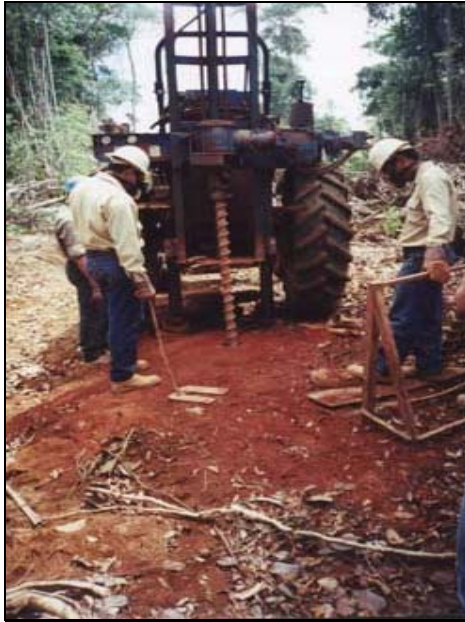
Figura 3.3: Perforación geoesploratoria.
