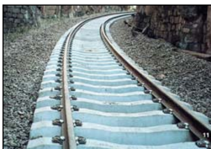
Fig. 4. 9. Línea férrea con durmientes de concreto.
