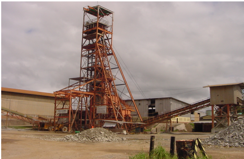
Figura 5. 13 Sistema de extracción de mineral (Izadora)
