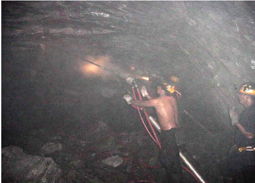
Figura 5. 5 Mineros utilizando equipo de perforación manual
