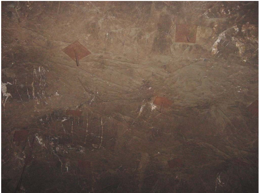
Figura 6. 2 Colocación de los pernos para el sostenimiento de bloques
